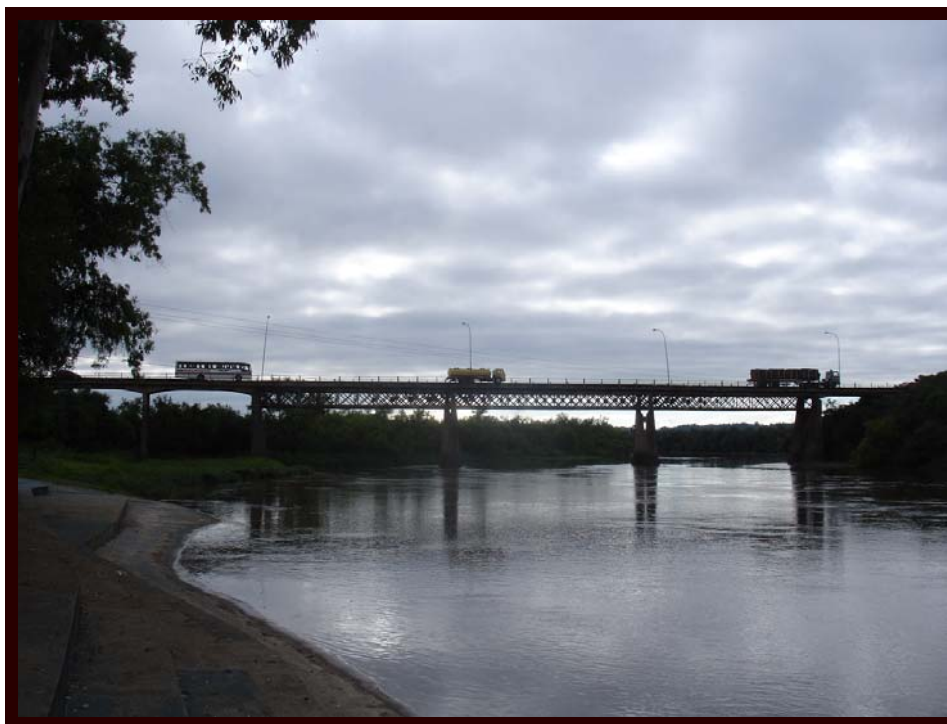
FOTO 5 - PONTE DE ACESSO AO MUNICÍPIO DE SÃO MATEUS DO SUL (BR-476), SOBRE O RIO IGUAÇU FONTE: MARCELO BARRETO, 2006
