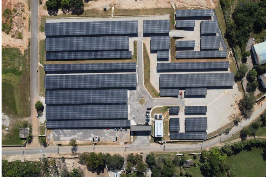
Figura 10 - Usina solar em formato de carport localizada em Sorocaba - SP
