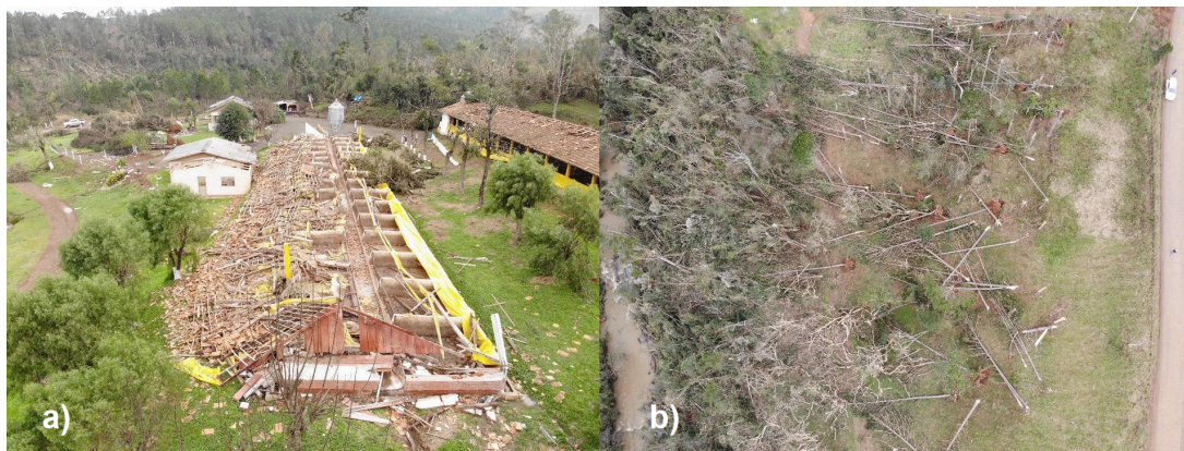
Figura 15 - Imagens aéreas pós-tornado no município de Água Doce, SC. Em “a” uma estrutura destruída e em “b” árvores arrancadas
