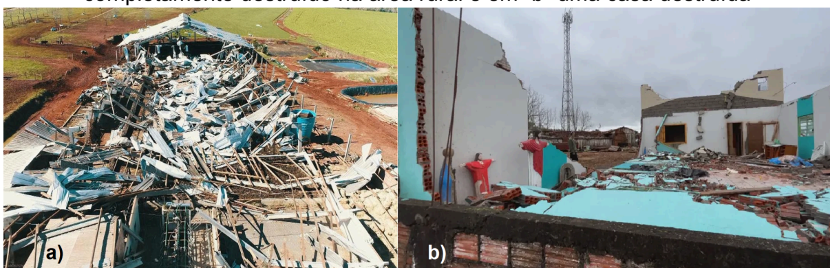
Figura 32 - Danos observados em Sede Nova, RS. Em “a” um galpão completamente destruído na área rural e em “b” uma casa destruída
