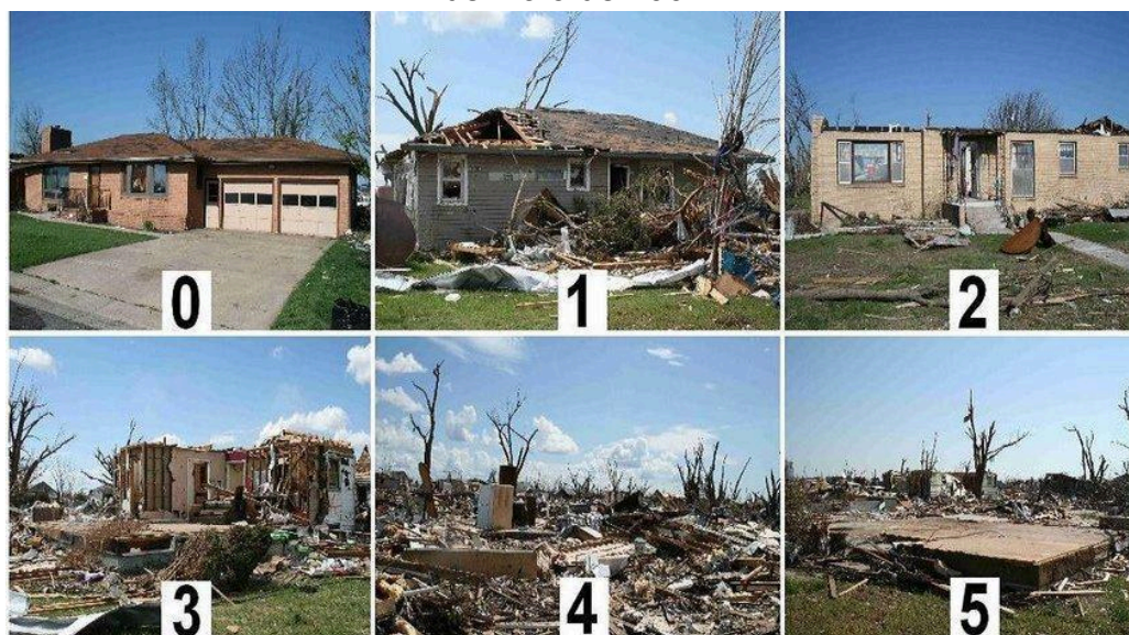
Figura 10 - Exemplo de diferentes categorias de danos (em escala EF) em residências de um evento tornádico em Greensburg, Kansas, Estados Unidos em 4 de maio de 2007
