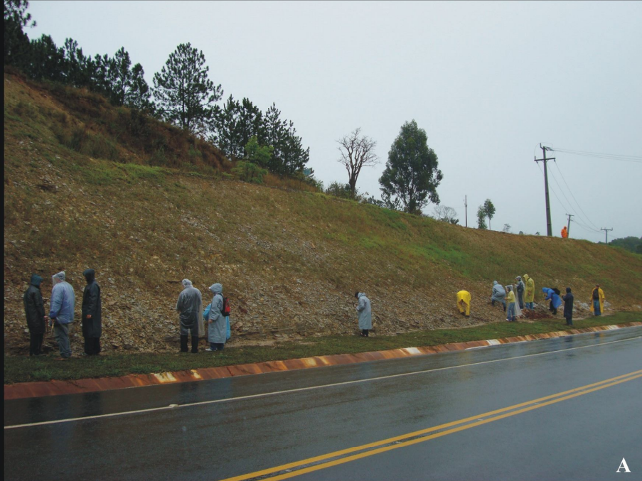
A - Vista geral do Ponto 6, localizado na PR-340, km 270 (Tibagi, PR).
