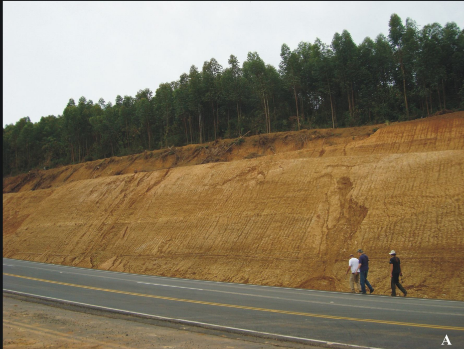
A - Vista geral do Ponto 8, localizado na PR-340, km 280 (Tibagi, PR).
