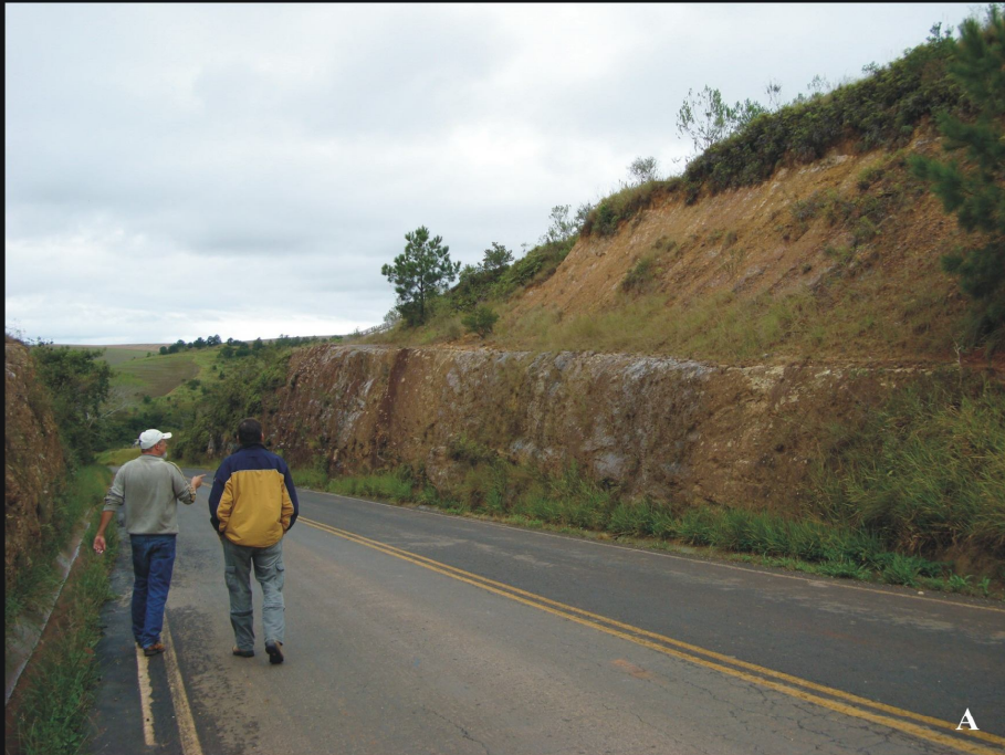
A - Vista geral do Ponto 4, localizado na PR-340, km 60 (Tibagi, PR).
