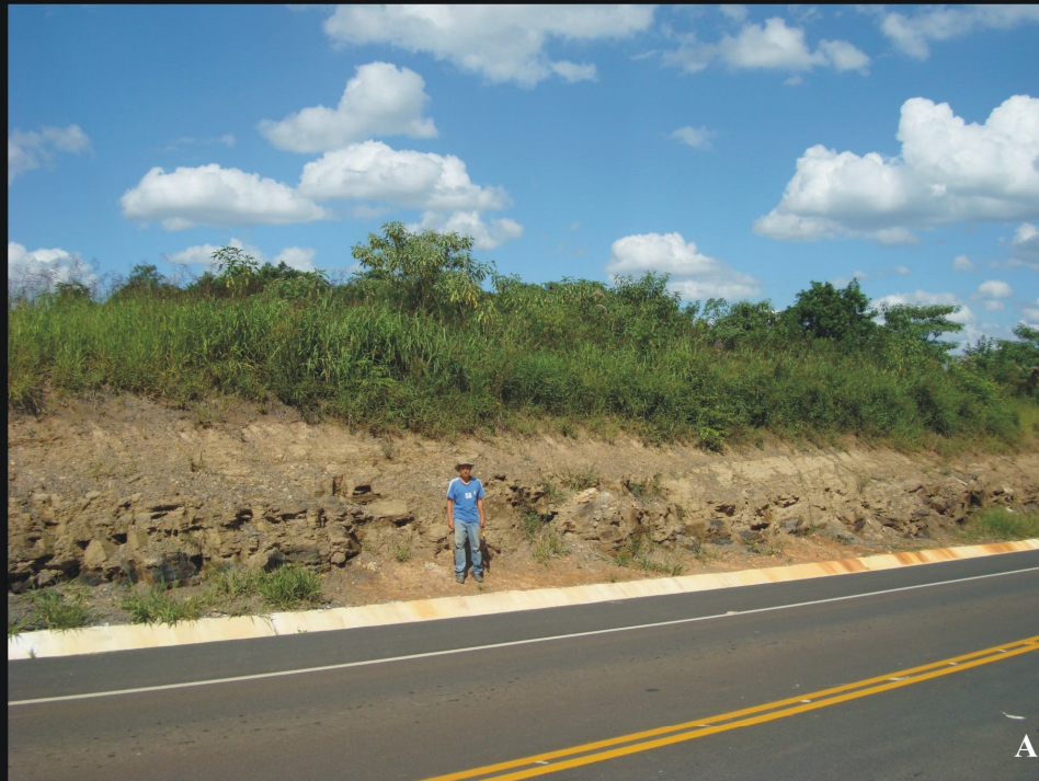
A - Vista geral do Ponto 14, localizado na BR-153, km 211,5 (Tibagi, PR).
