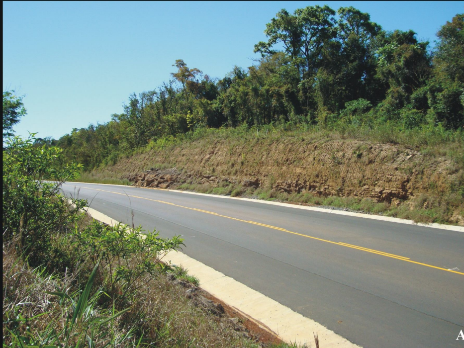
A - Vista geral do Ponto 13, localizado na BR-153, km 211 (Tibagi, PR).
