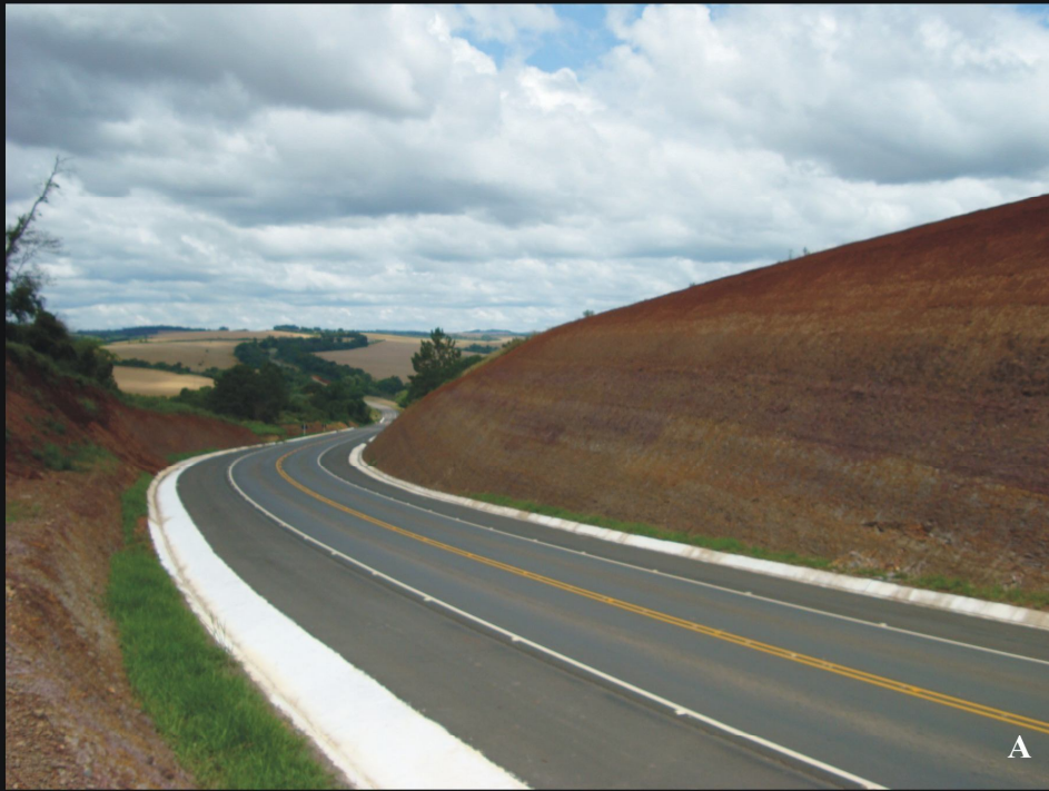
A - Vista geral do Ponto 18, localizado na BR-153, km 223 (Tibagi, PR).
