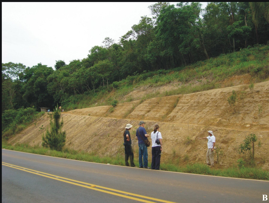
B - Vista geral do Ponto 7, localizado na PR-340, km 272.
