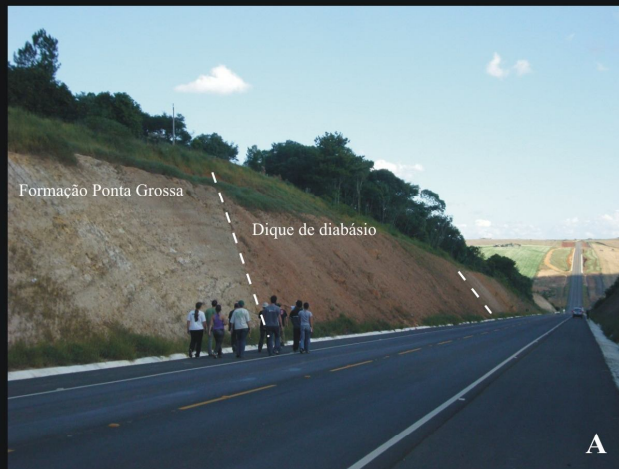
A - Vista geral do Ponto 16, detalhe da movimentação ocasionada pelo dique.
