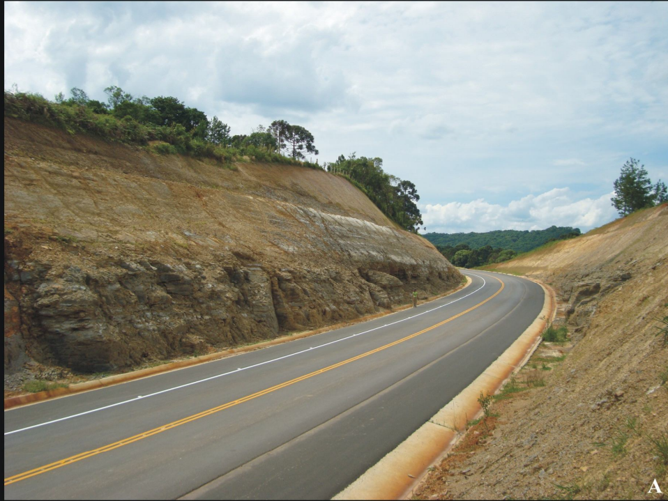
A - Vista geral do Ponto 15, localizado na BR-153, km 214 (Tibagi, PR).
