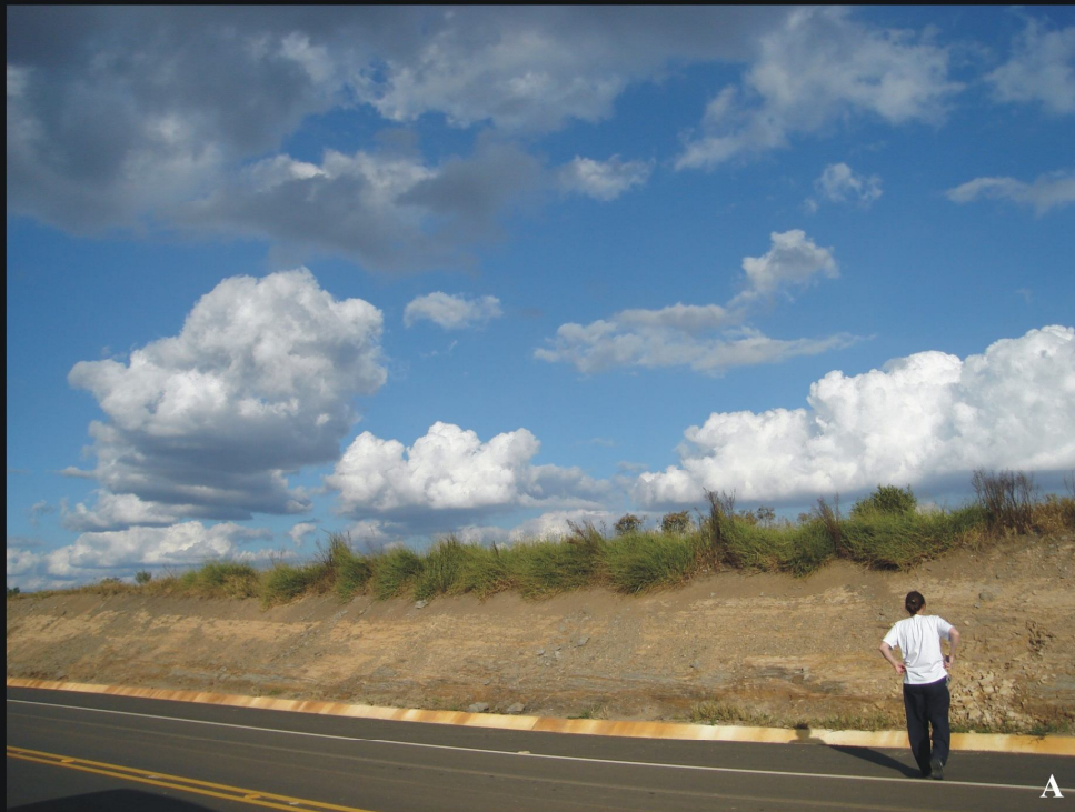
A - Vista geral do Ponto 17, localizado na BR-153, km 220 (Tibagi, PR).
