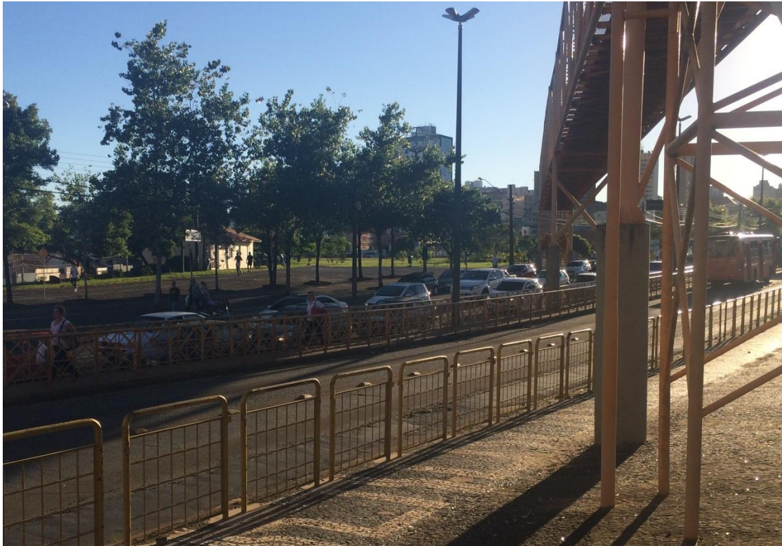
Figura 67: Guarda-corpo para impedir a travessia dos pedestres.
