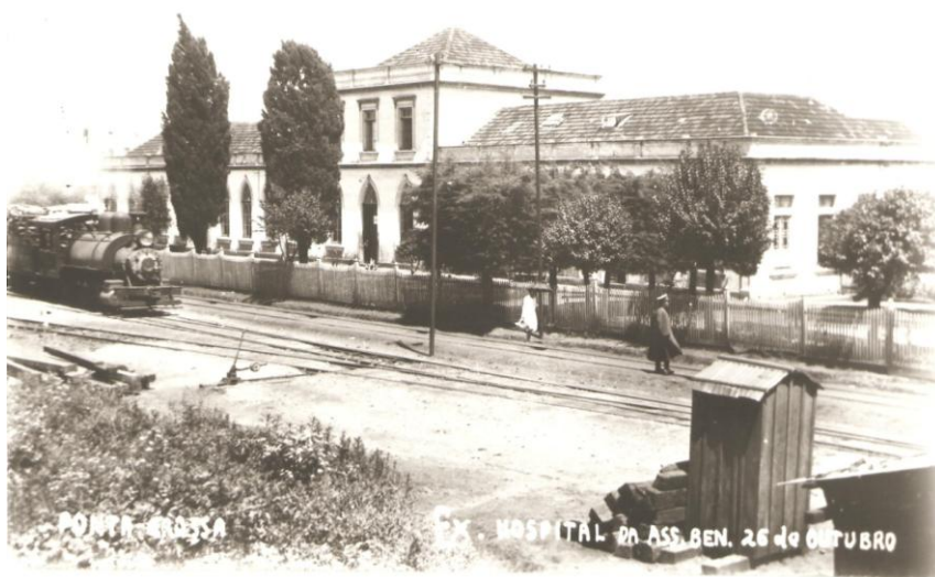
Figura 76: O edifício principal do Hospital, já com anexos construídos.
