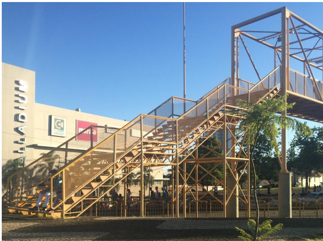
Figura 100: Grande quantidade de degraus da passarela.
