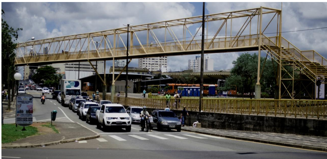
Figura 64: Passarela sobre a Av. Vicente Machado.
