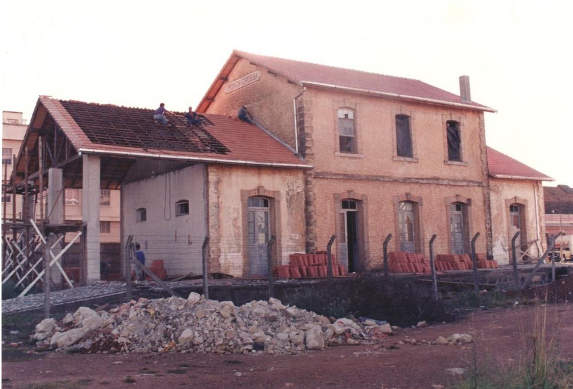
Figura 43: Estação Paraná em 1995, sendo restaurada.
