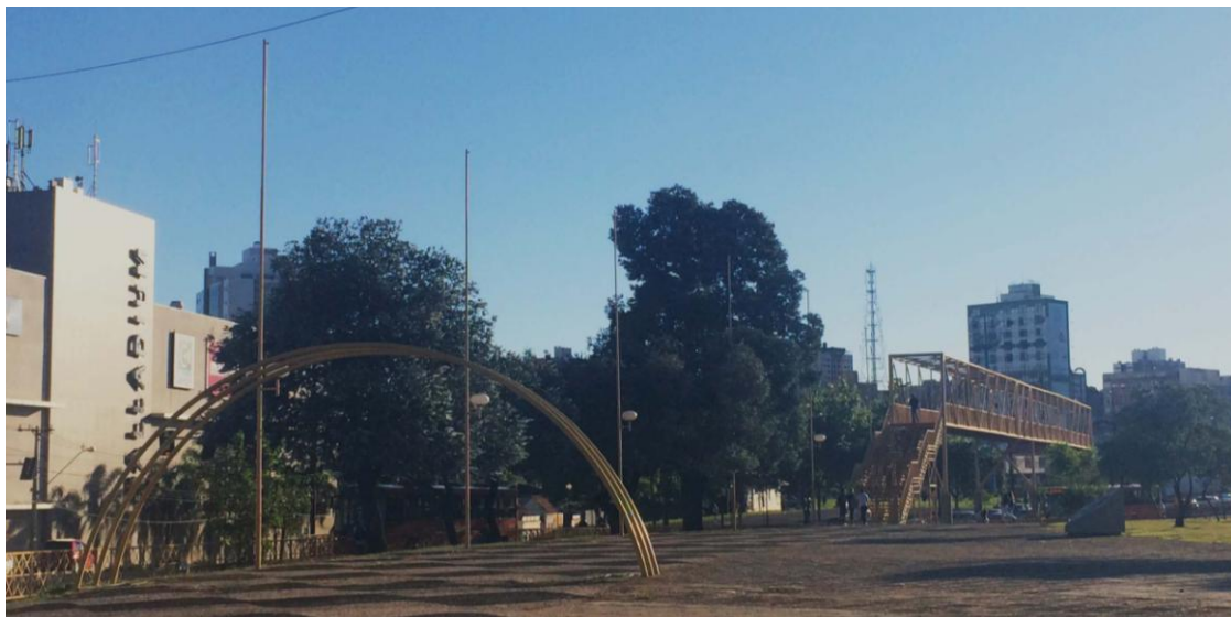
Figura 26: A passarela e o portal conectam a Praça do Ar às demais praças.
