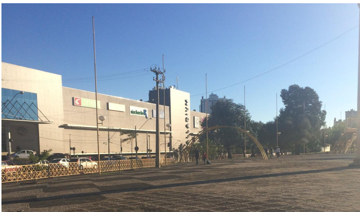
Figura 99: Não existe permeabilidade visual entre o Shopping e o parque.
