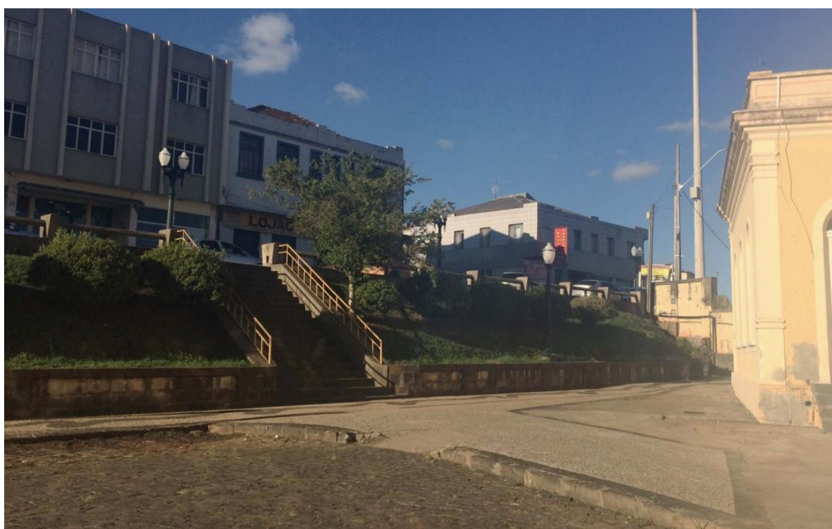
Figura 91: Talude gramado em frente à Estação Ponta Grossa.
