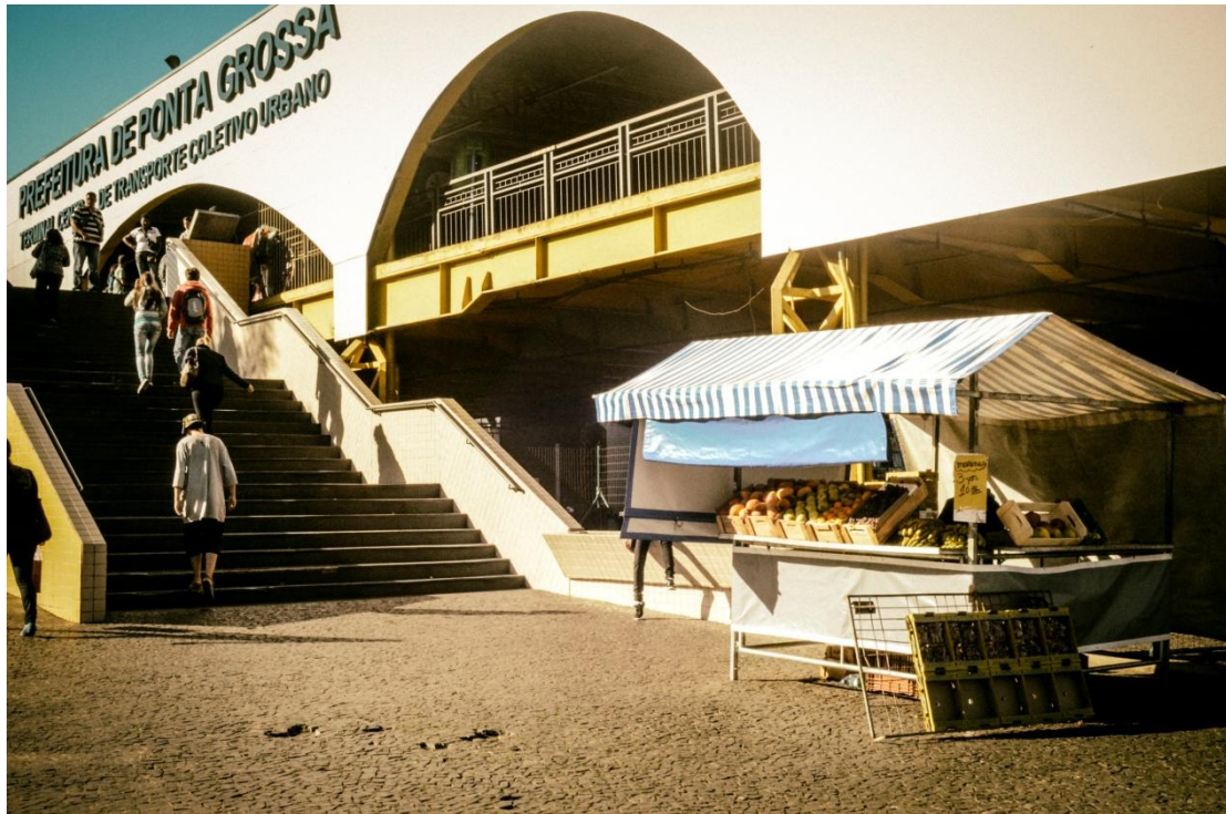
Figura 52: Falta de acessibilidade ao edifício do Terminal Central.
