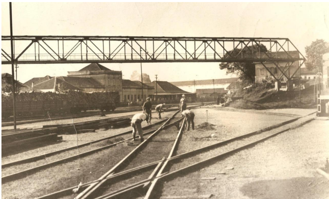
Figura 66: O pátio e a passarela na época de funcionamento da ferrovia.
