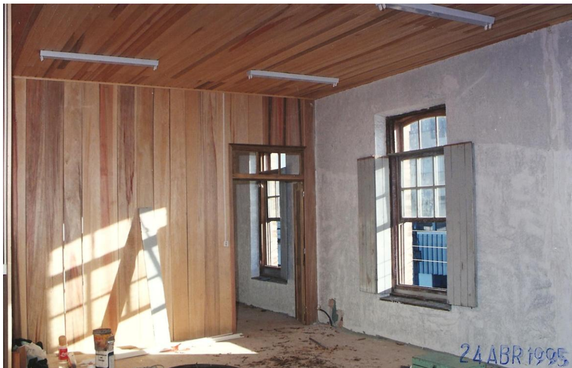
Figura 44: Estação Paraná em 1995, sendo restaurada.
