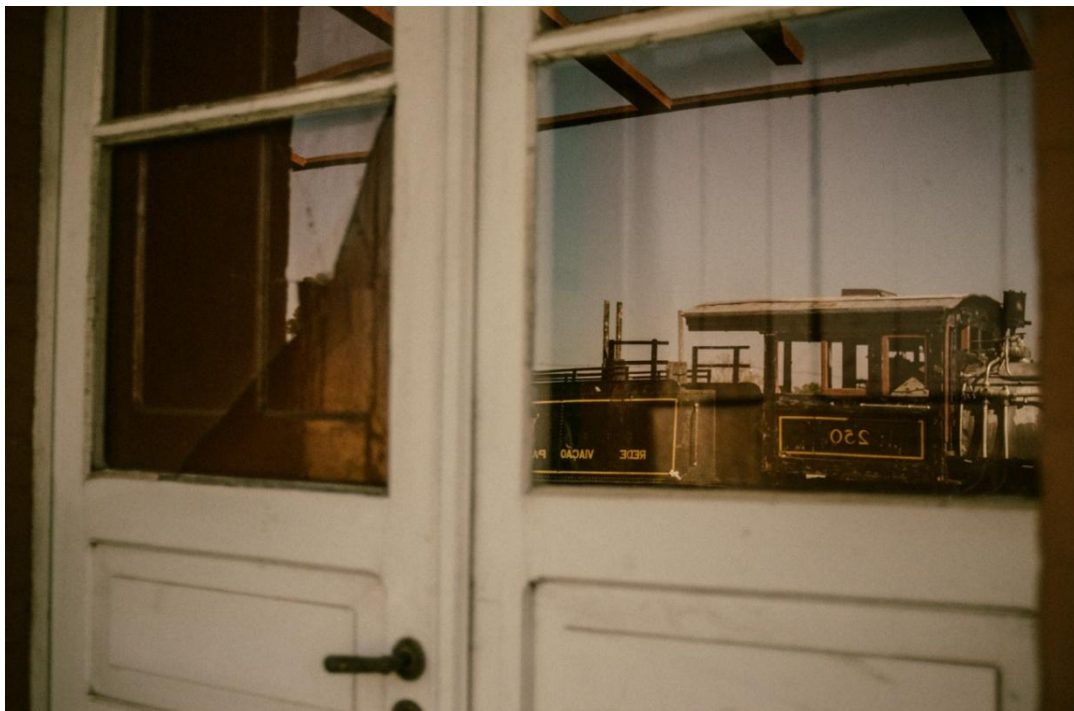
Figura 49: Depredação dos vidros e esquadrias da Estação Paraná.
