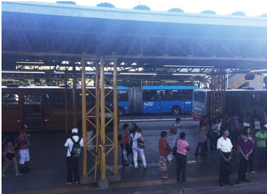
Figura 54: Condições precárias de permanência no interior do Terminal.
