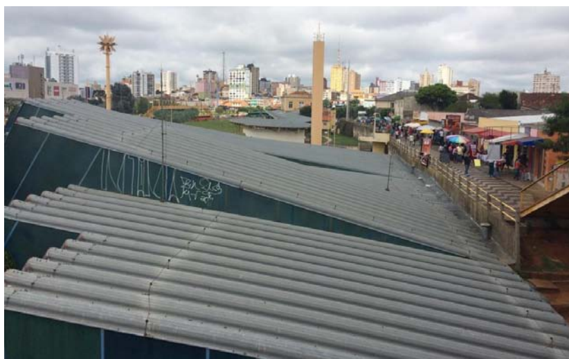
Figura 63: Cobertura vista da antiga passarela.
