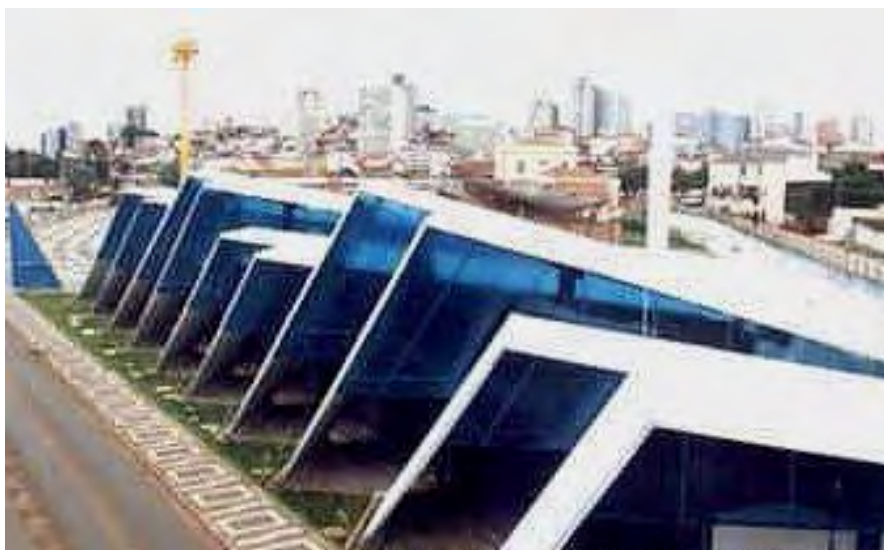
Figura 16: Estrutura exterior do CCP.
