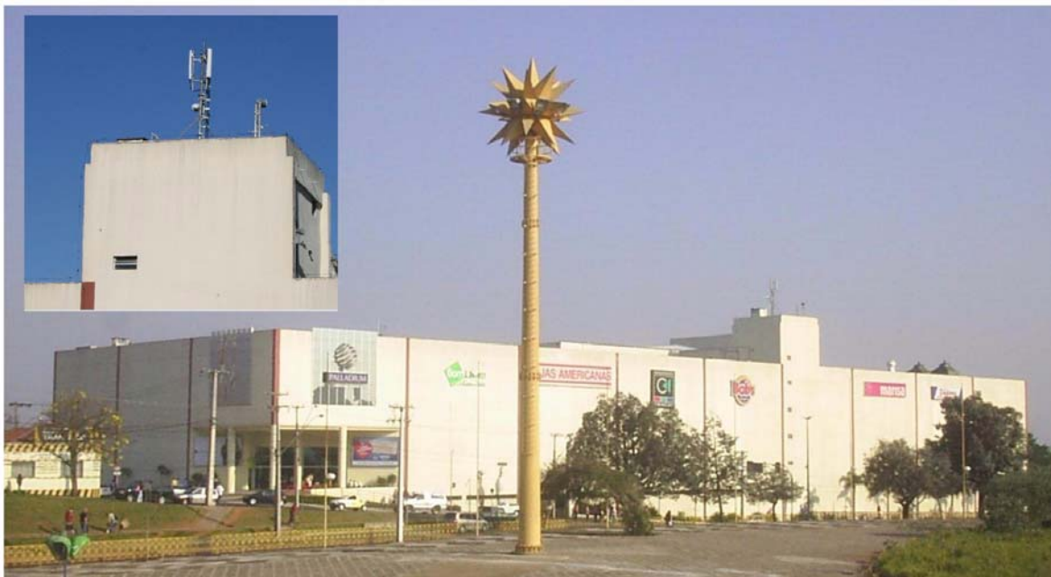
Figura 12 - Shopping Palladium com uma ERB instalada sobre sua caixa d'água (no detalhe à direita). FONTE: autor (2009).
