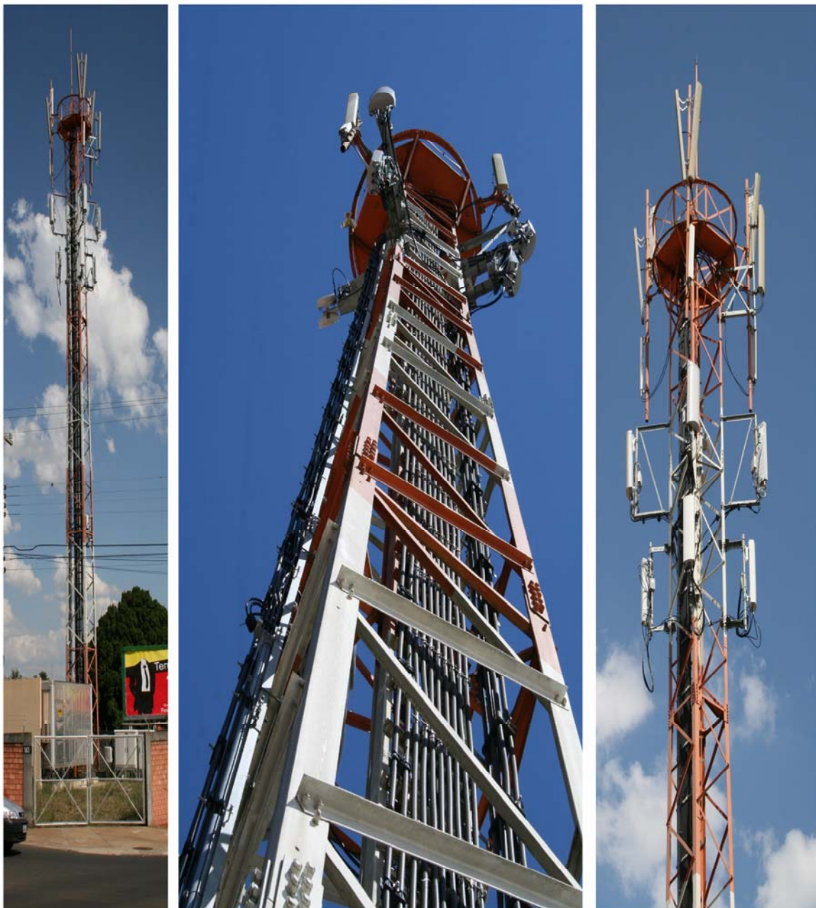
Figura H - Uma torre de telefonia celular com suas antenas alongadas. FONTE: Kaczmarech (2008).
