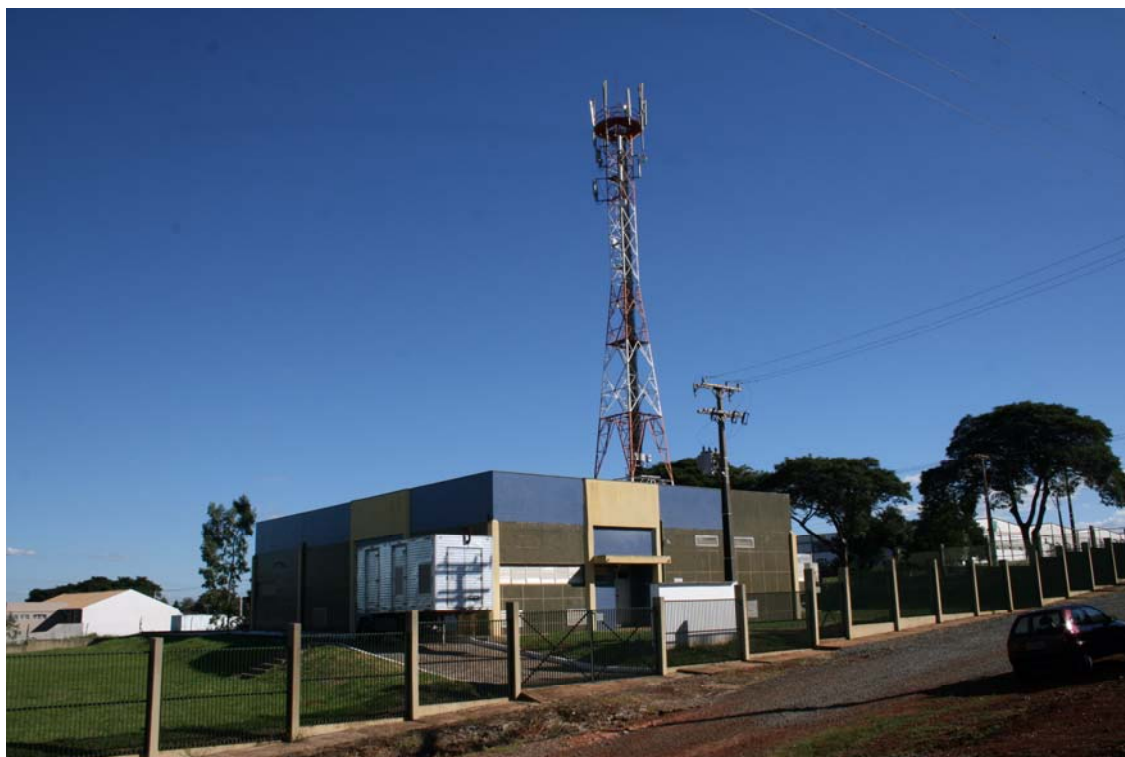
Figura B – Central de Comutação e torre de telefone celular. FONTE: Kaczmarech (2009).
