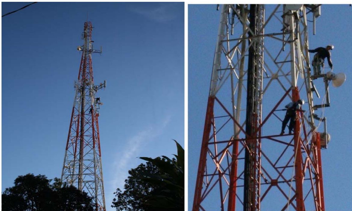
Figura 05 – Torre (objeto 28) com a presença de dois técnicos em telefonia, os quais servem de escala para dar uma referência sobre a extensão vertical de uma torre destas. FONTE: Kaczmarech (2008).
