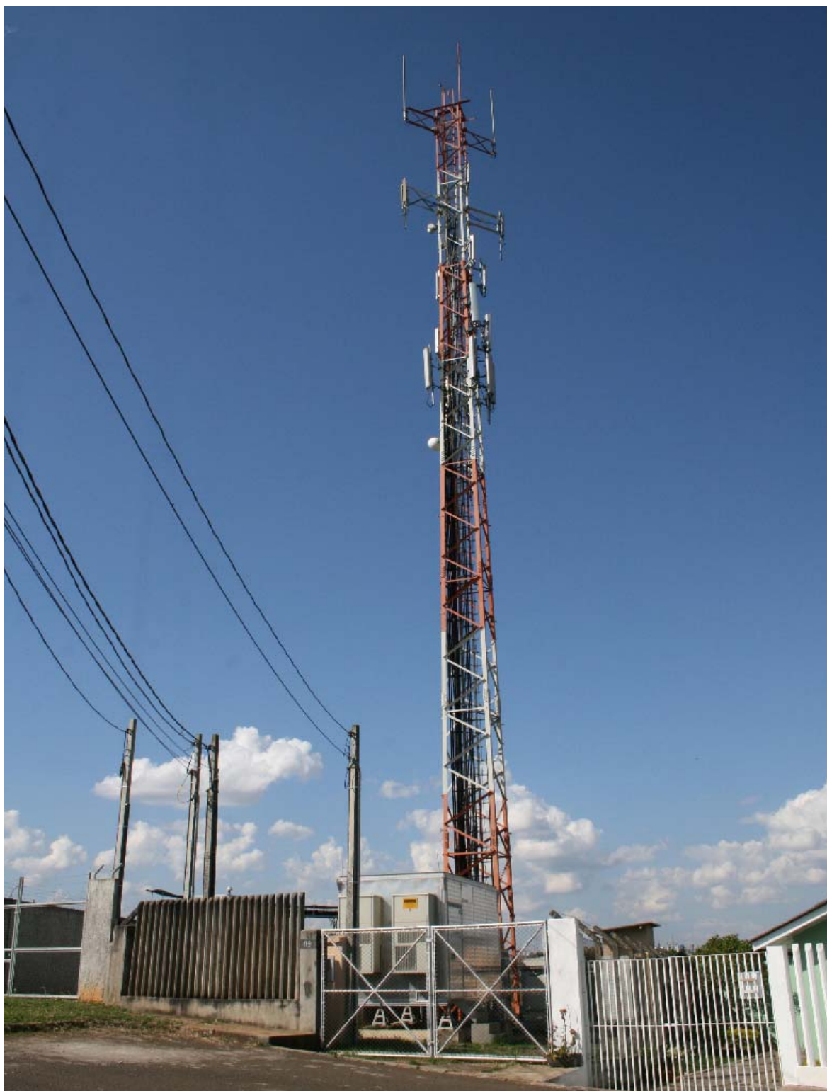
Figura 10 – ERB de telefonia móvel (objeto 24), compartilhada entre quatro empresas de telefonia, o que é comprovado pelos quatro postes de fornecimento de energia elétrica. FONTE: Kaczmarech (2009).
