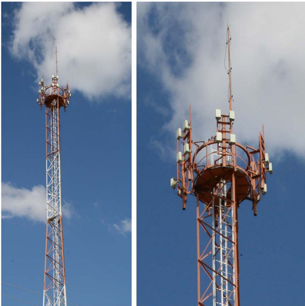
Figura G - A telefonia fixa regional, apresenta em suas torres, antenas de forma quadrada, como as vistas neste exemplo. FONTE: Kaczmarech (2009).
