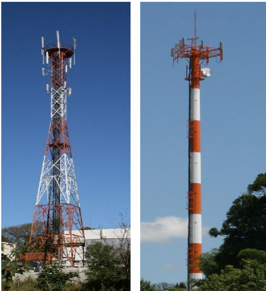
Figura F – Exemplo de uma torre de telefonia celular do tipo autosuportada (à esquerda) e uma torre metálica de tubos. FONTE: Kaczmarech (2008).
