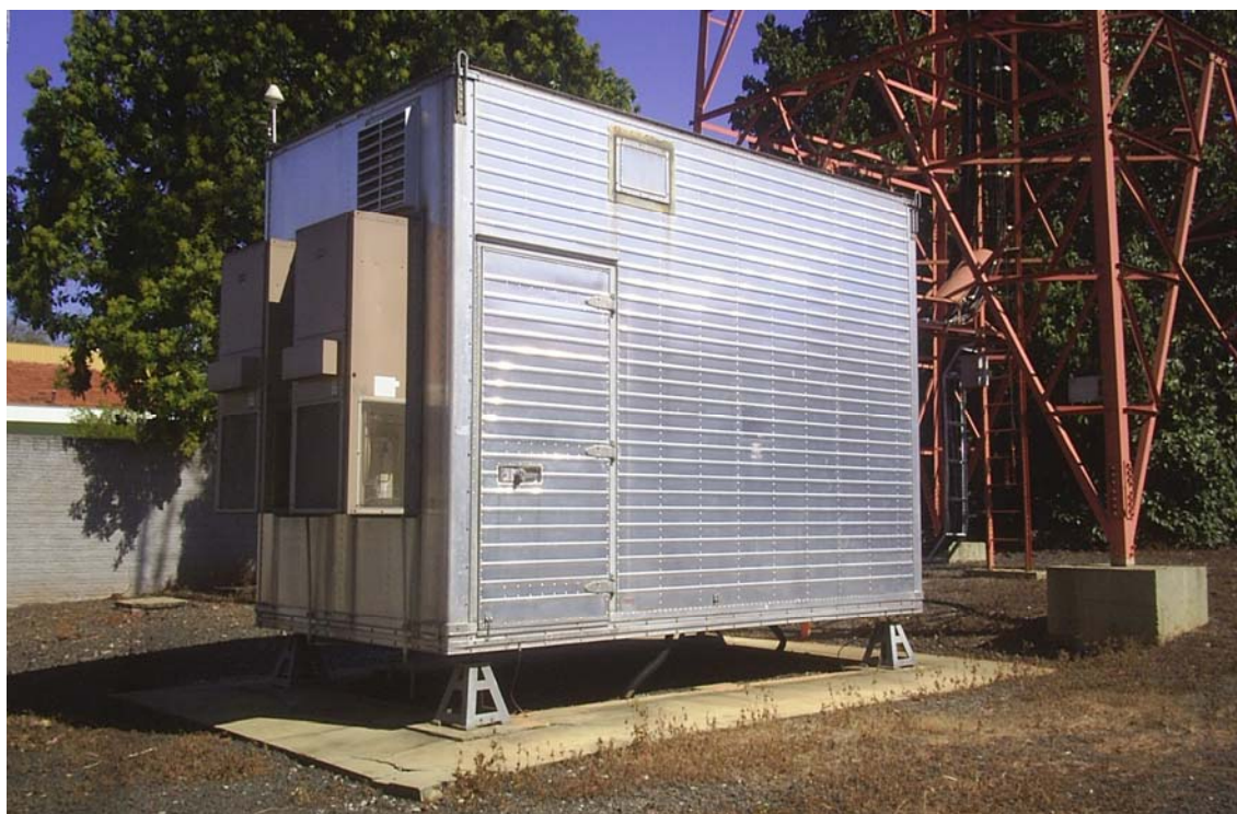
Figura D – Container de equipamentos eletrônicos de uma ERB. FONTE: Kaczmarech (2009).
