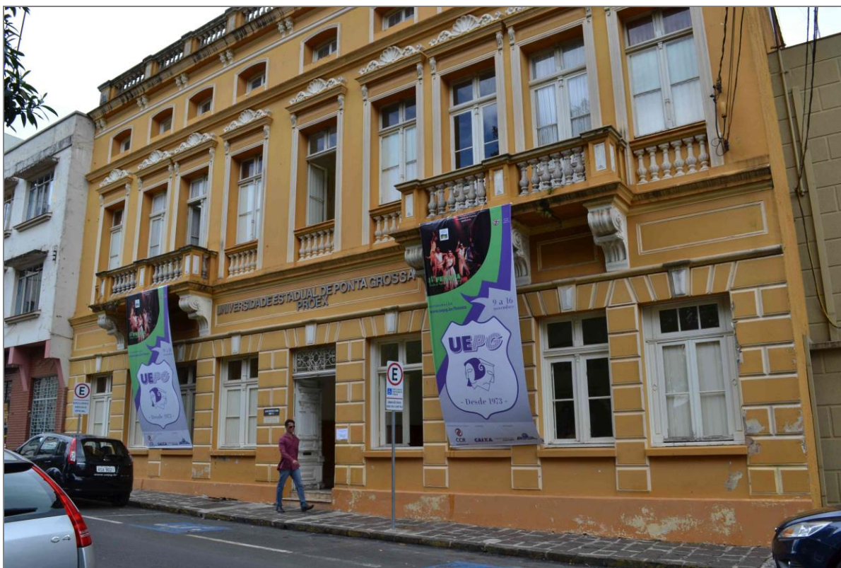
FIGURA 11 - EDIFÍCIO GUILHERME NAUMANN NOS DIAS ATUAIS Fonte: Acervo da autora, 2016.
