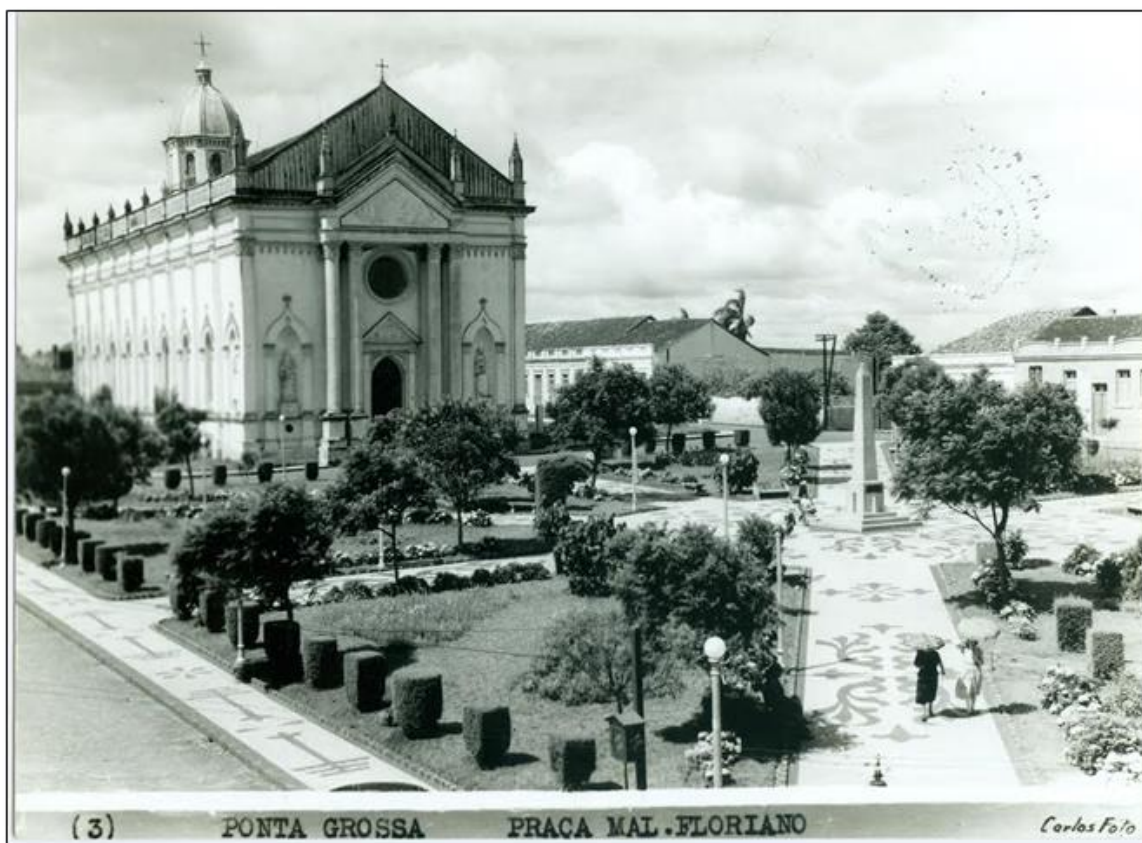
FIGURA 8 - AO CENTRO DA PRAÇA MONUMENTO AOS FUNDADORES, CONSTRUÍDO EM 1930.
