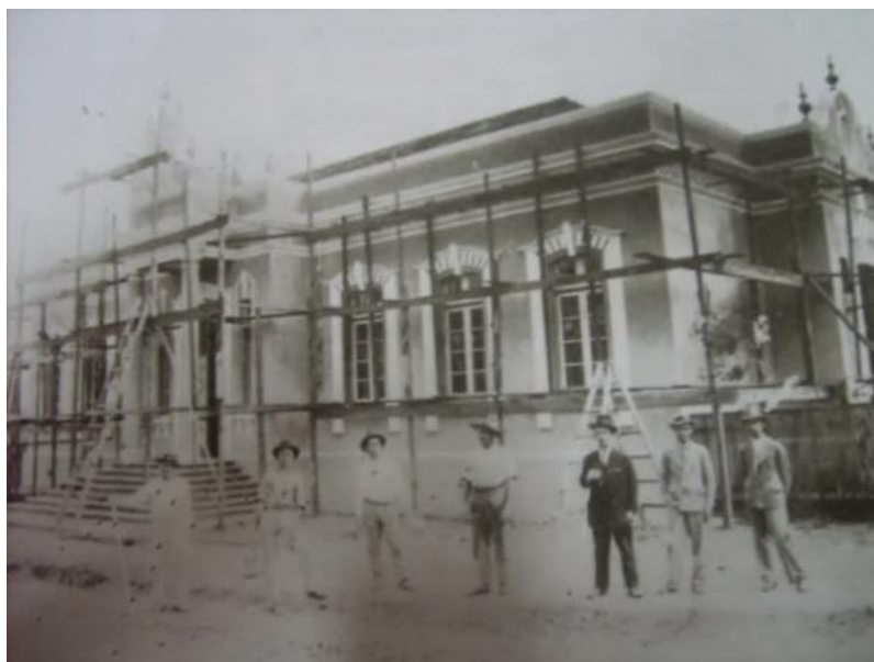
Figura 1 - Construção do Grupo Escolar Dr. Claudino dos Santos em 1913
