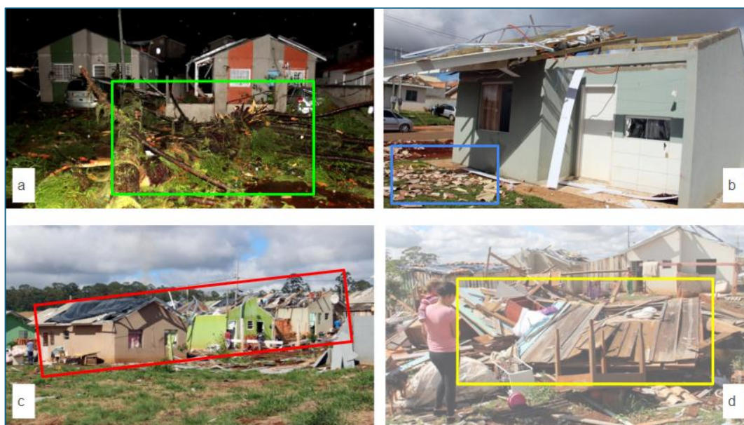
Figura 0.31 Danos causados por tornado em 27/09/2015 no município de Ponta Grossa.
