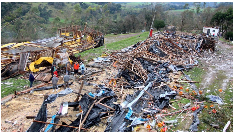
Figura 0.17 - Aviário destruído por tornado em 13 de julho de 2015 em Francisco Beltrão - PR.
