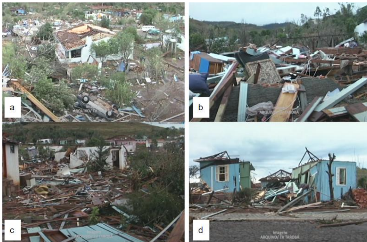
Figura 0.8 - Residências atingidas pelo tornado ocasionadas por tornado em junho de 1997, em Novas Laranjeiras, Paraná. Em “a” uma residência parcialmente destelhada e ao redor outras destruídas e um veículo tombado. Em “b” escombros de residência, Em “c” escombros de residência e paredes de alvenaria danificadas, em “d” residência destruída ao meio.
