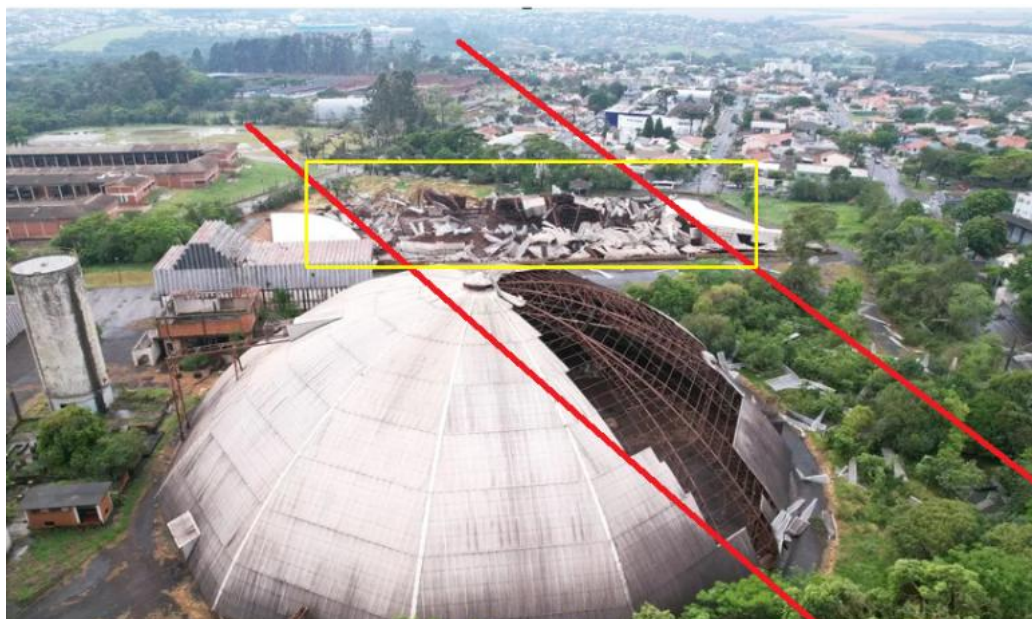
Figura 0.28 - Rastro de destruição do tornado de 04/12/2023 em Cascavel
