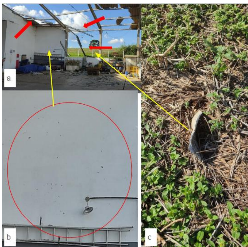
Figura 0.40 Destruição do telhado em empresa de pesquisa agrícola e mísseis lançados pelo tornado em 05/04/2024, em Ponta Grossa.
