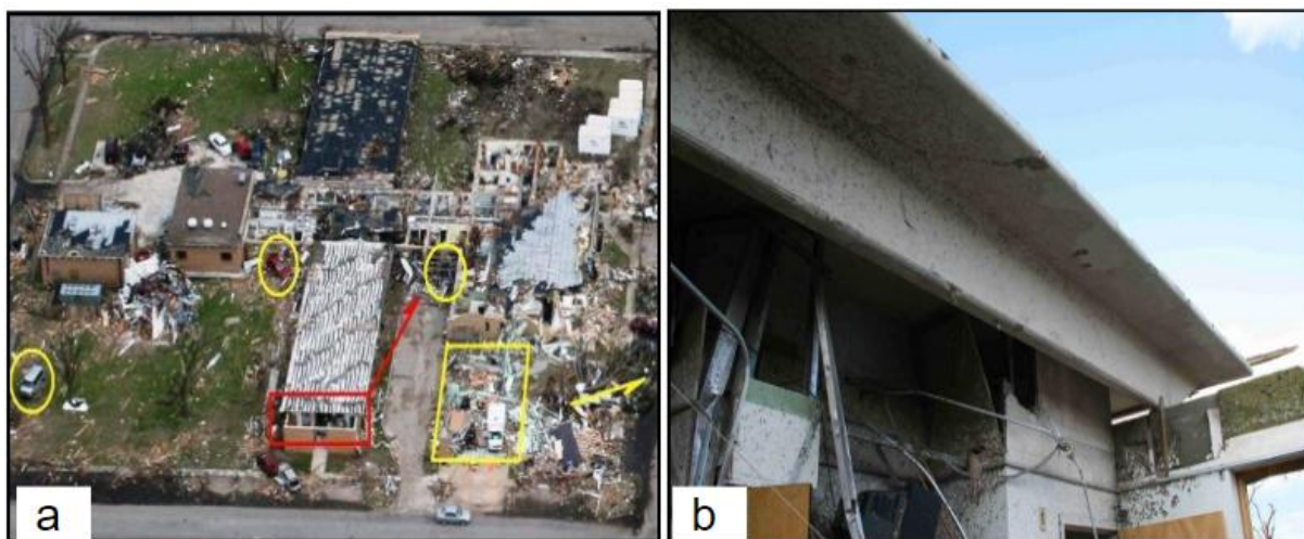
Figura 0.5 - Em “a” área do hospital e sinalizada pelo retângulo vermelho local da viga deslocada, veículos arremessados (círculos amarelos) e o deslocamento de viga de concreto em “b”.
