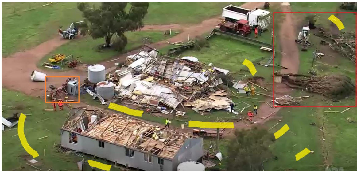
Figura 0.4 - Danos provocados por tornado em Bathurst - New South Wales / Austrália em 30/09/2021. Contendo árvores arrancadas (quadrado vermelho) estrutura completamente destruída, caminhão tombado (quadrado laranja) e os materiais orientados (em amarelo).
