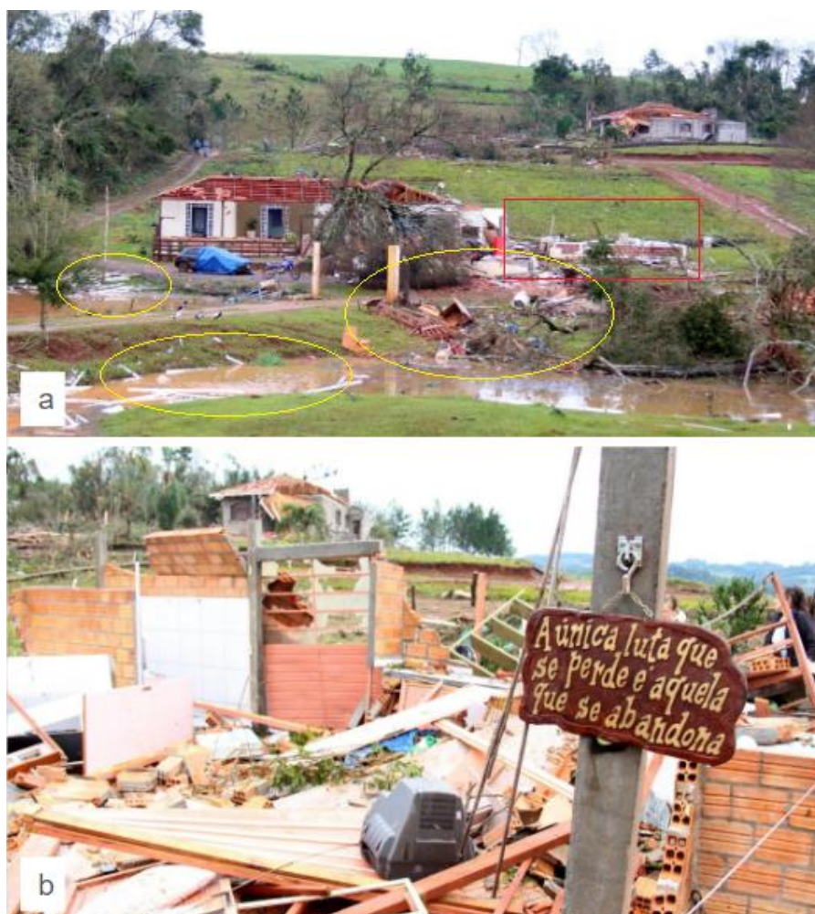
Figura 0.18 - Danos causados por tornado em área rural de Francisco Beltrão, destacando a destruição de residências e a dispersão de escombros pelo vórtice do tornado em 13 de julho de 2015.
