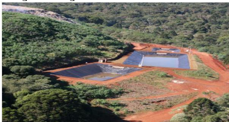
Figura 3 - Lagoas de tratamento do Chorume
