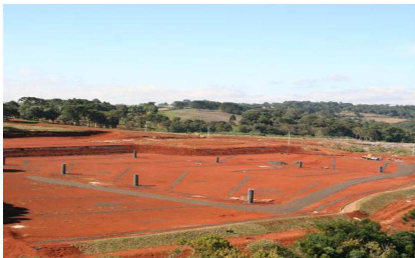
Figura 2 - Célula do aterro sanitário de Guarapuava-PR
