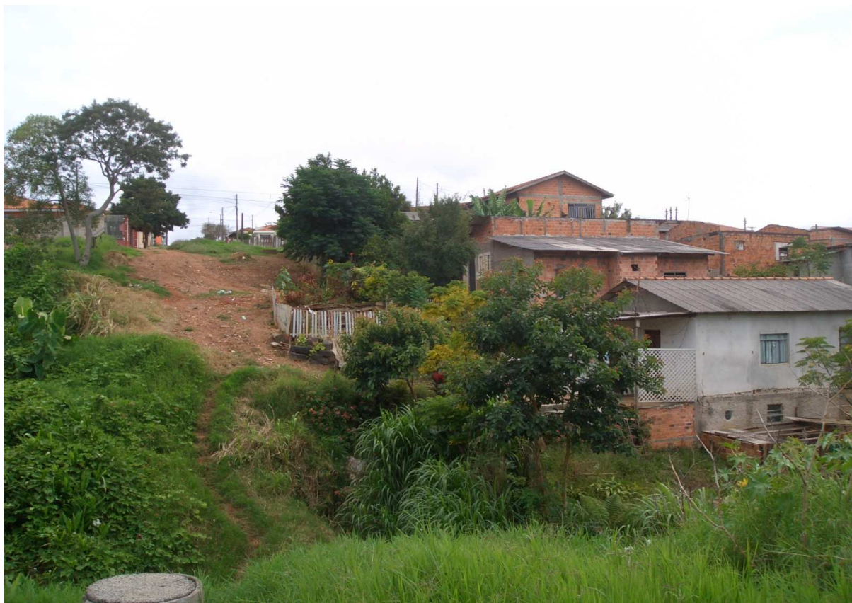
FIGURA 8 – Ocupações irregulares próximas ao arroio. Fonte: Foto do acervo particular de Virginia de Souza – 25/01/08.
