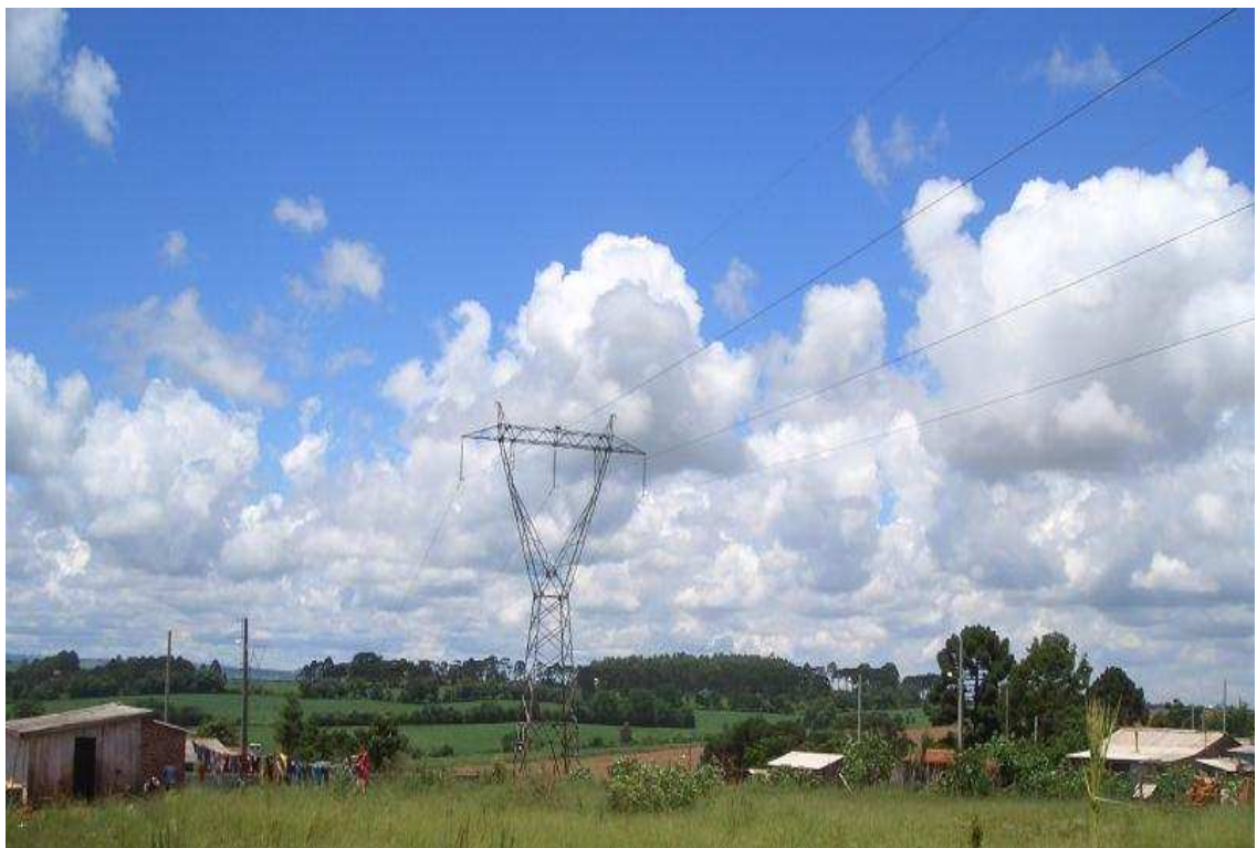
FIGURA 21 – Residências próximas a torre de alta tensão. Fonte: Foto do acervo particular de Virginia de Souza – 31/01/2008.
