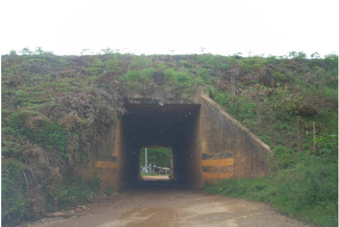
FIGURA 16 – Saída do Loteamento San Martim. Fonte: Foto do acervo particular de Virginia de Souza – 24/01/2008.
