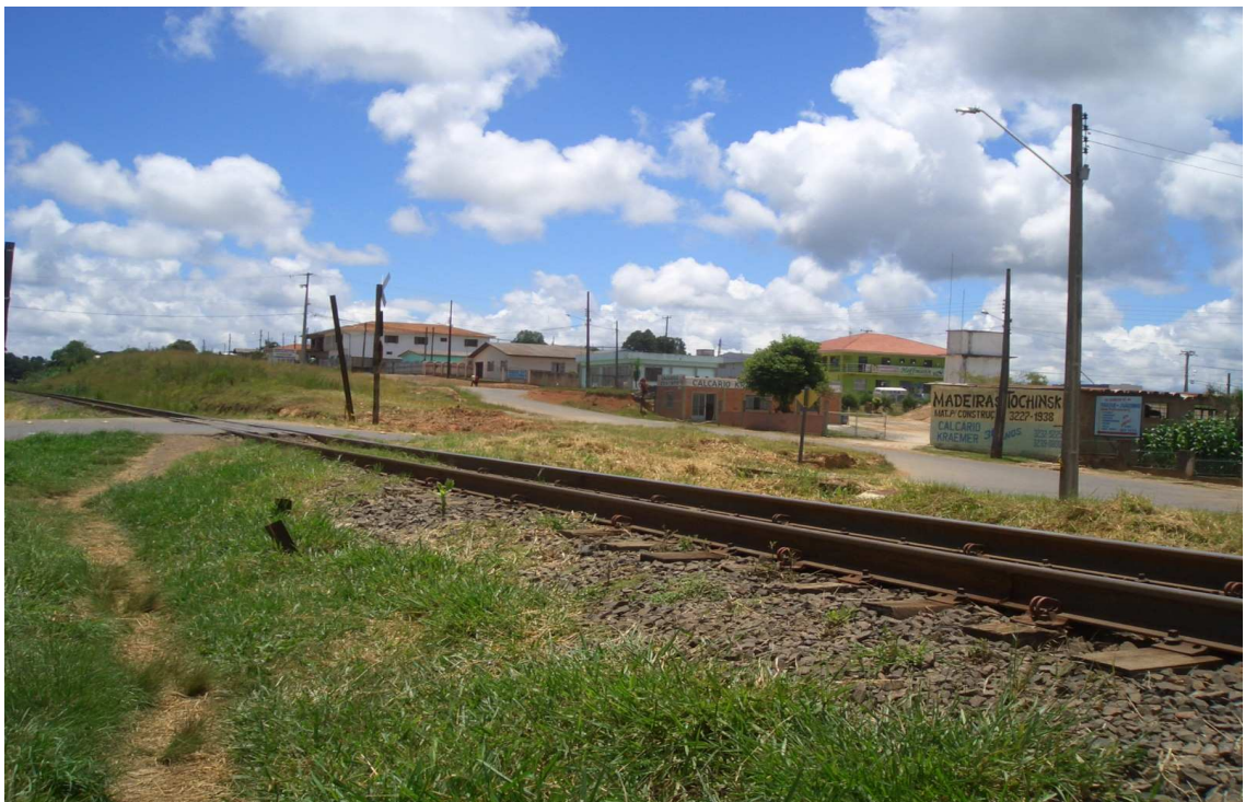
FIGURA 23 - Residências próximas à linha férrea. Fonte: Foto do acervo particular de Virginia de Souza – 31/01/2008.
