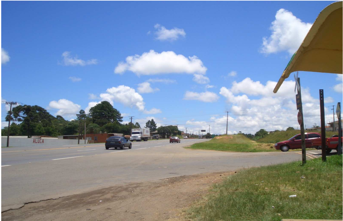
FIGURA 20 – Zona de Risco – Pr 376 – Entrada da Vila Borato. Fonte: Foto do acervo particular de Virginia de Souza – 31/01/08.
