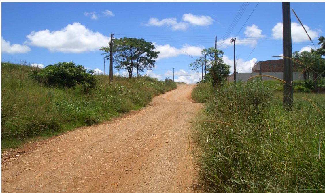
FIGURA 24 – Ruas sem pavimentação.
