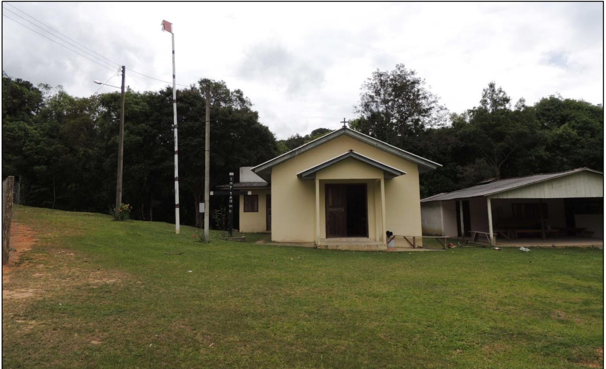
FIGURA 9 – Capela de Nossa Senhora Aparecida
