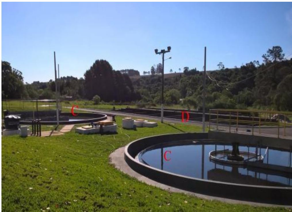
Figura 12- decantadores (C) e leito de secagem de lodo (D).
