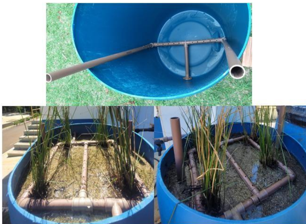
Figura 14 - Instalação da tubulação no WCFV.
