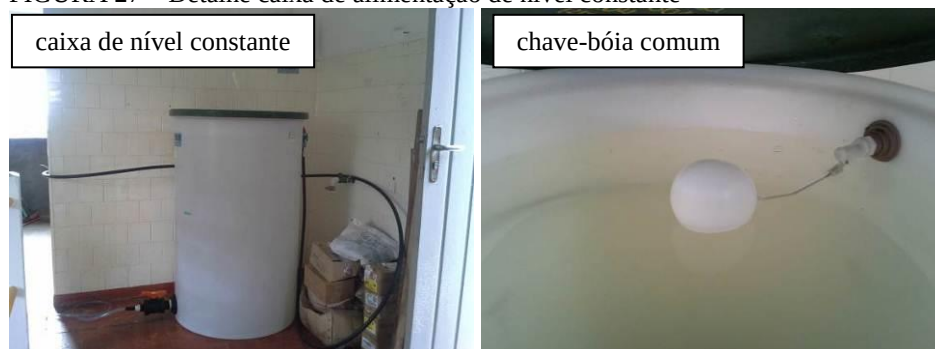
FIGURA 27 – Detalhe caixa de alimentação de nível constante
