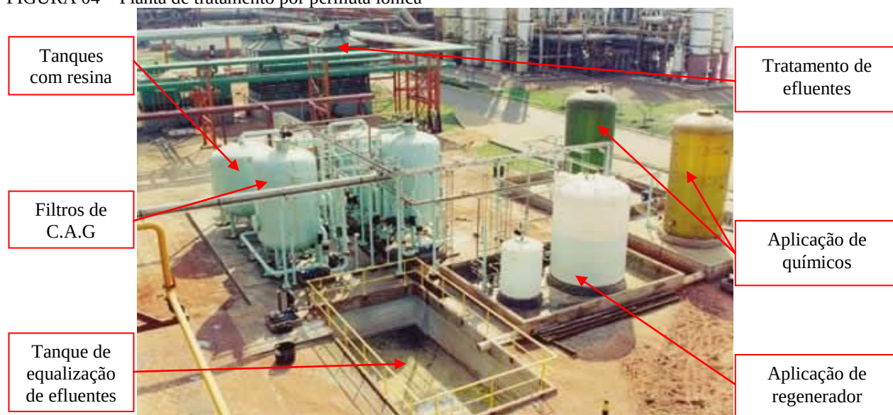
FIGURA 04 – Planta de tratamento por permuta iônica
