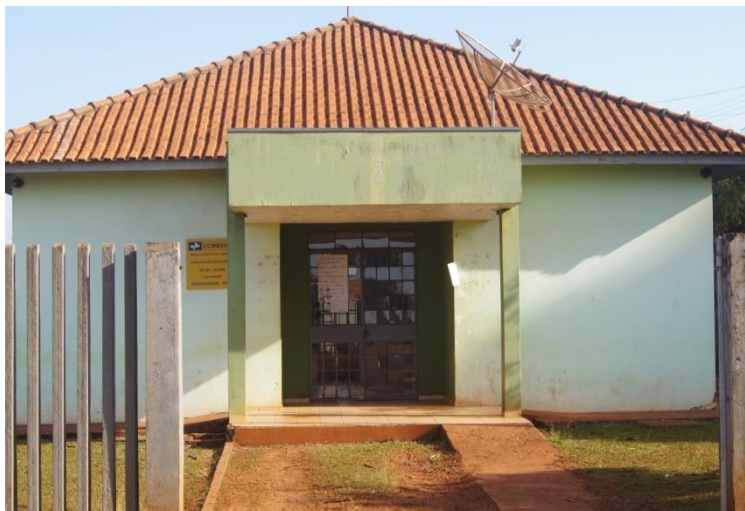
Imagem 5 - Posto de Saúde localizado na comunidade
