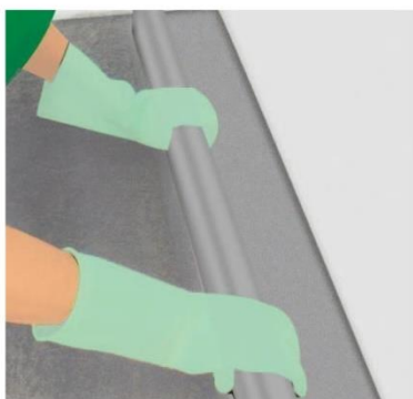
Figura 06 – Sarrafeamento da argamassa.
