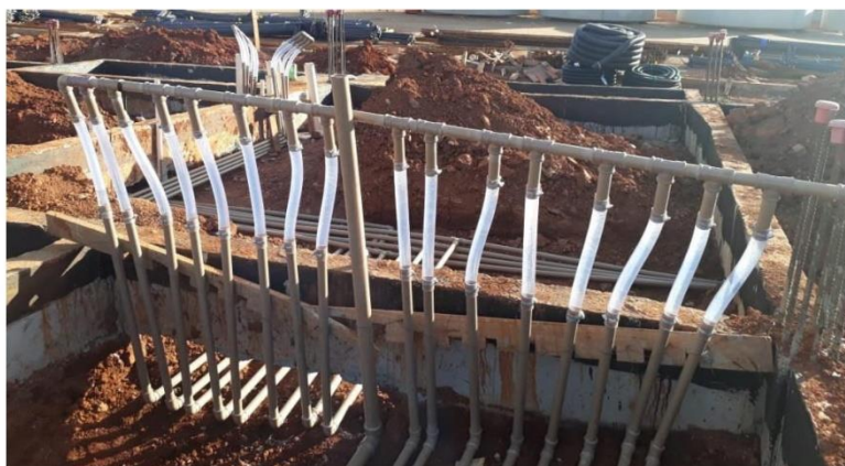
Teste em instalação hidráulica enterrada
