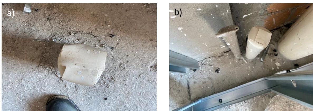
Figura 4 - Tubulações: a) de esgoto e b) de água e esgoto protegidos manualmente.
