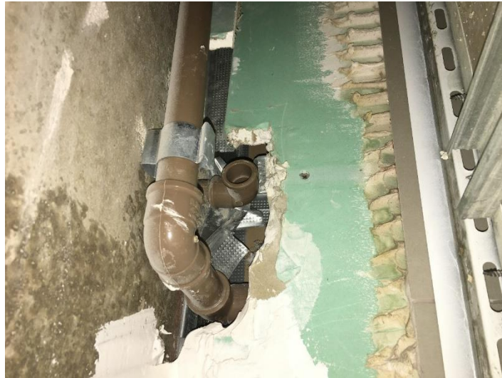
Figura 9 - Tubulação de água sem finalizar.
