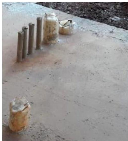
Exemplo de proteção das tubulações
