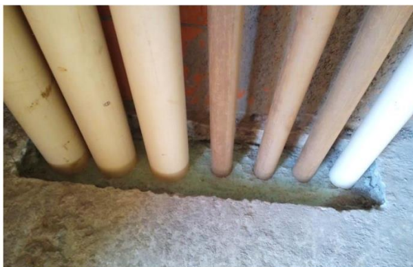
Retirada da parte A do passante de espuma
