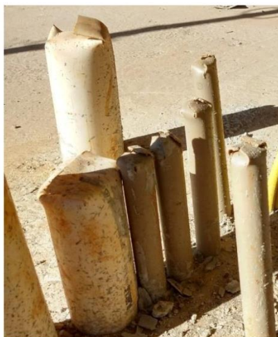
Exemplo de proteção das tubulações
