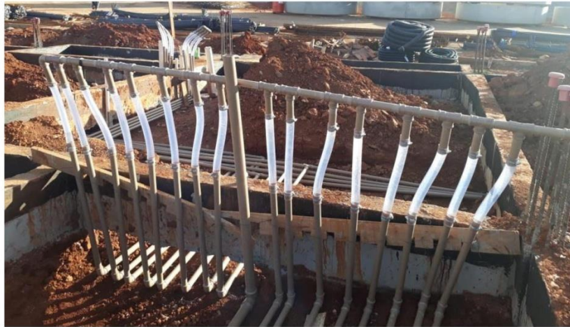
Teste em instalação hidráulica enterrada
