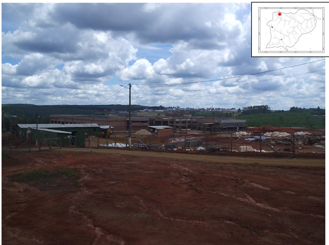
Figura 20. Área de solo exposto, com presença de erosão em sulcos, em função da construção do Hospital Regional de Telêmaco Borba – Bacia Hidrográfica do Arroio Uvaranal
