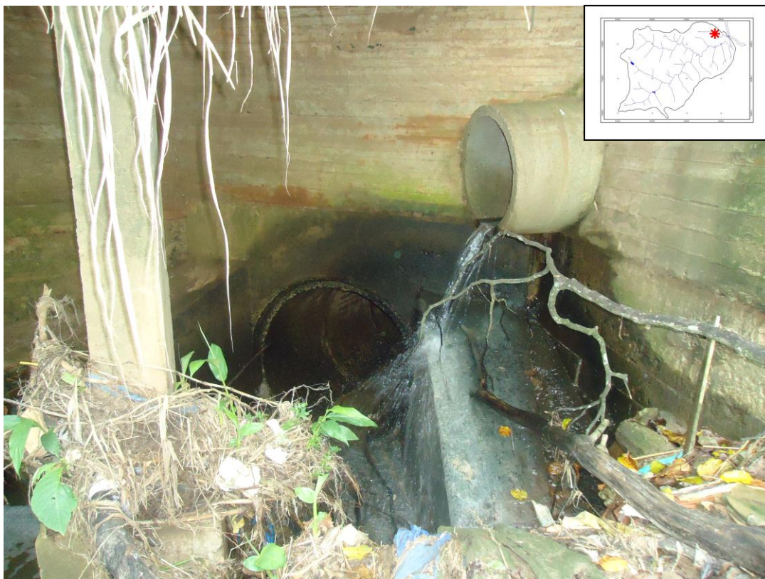
Figura 8. Canalização em trecho do Arroio do SESI – Bacia Hidrográfica do Arroio Uvaranal, Telêmaco Borba – PR Autor: Bahr (2011)
