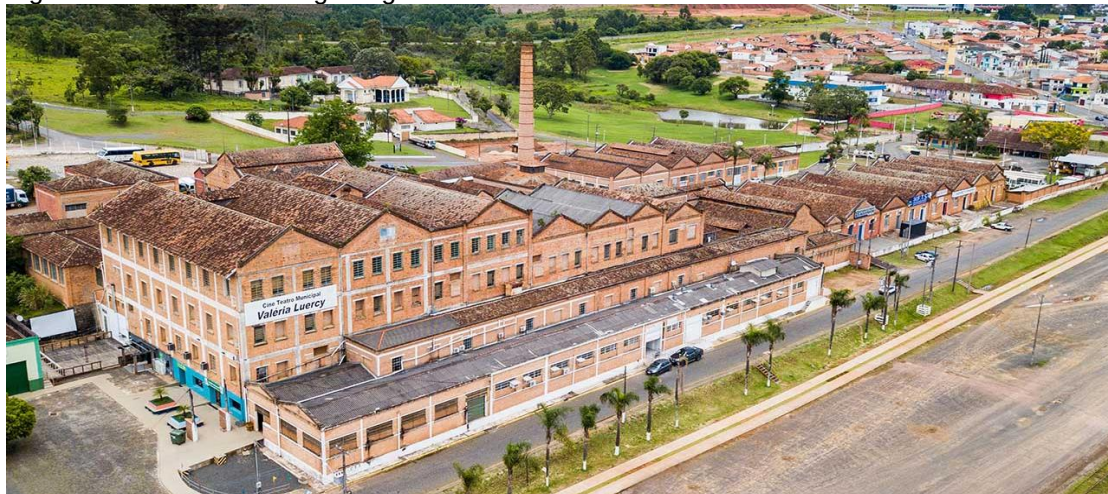
Figura 14 – Prédio do antigo Frigorífico Matarazzo
