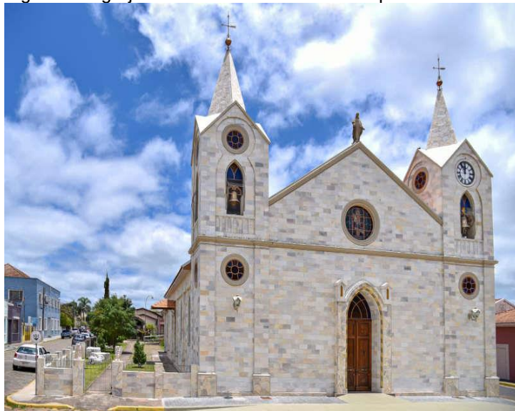
Figura 5 – Igreja Bom Jesus da Pedra Fria após a sua revitalização
