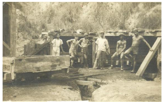
. Entradas das galerias
