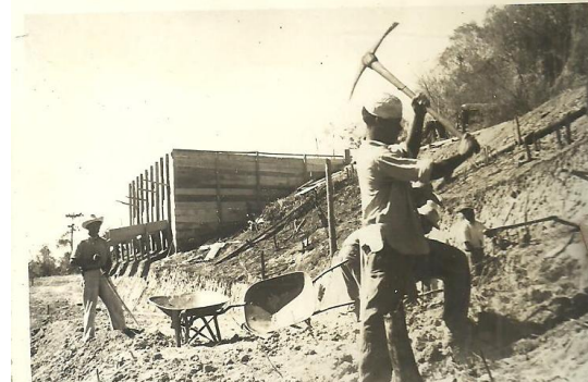
. Construção das Bancas
