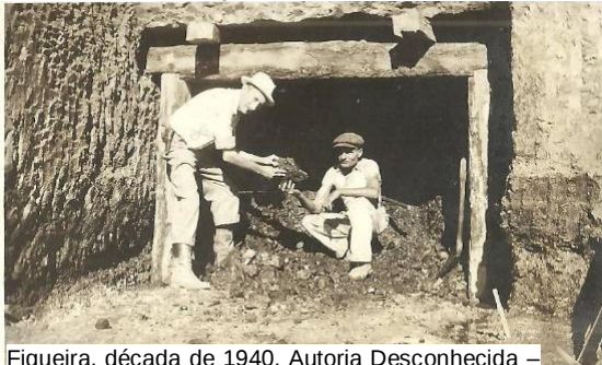
. Emboque Inicial de Galeria
