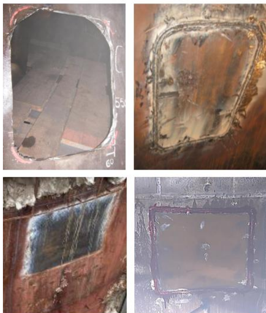
Figura 2: Reparos por substituição de segmentos da parede pressurizada de digestor.
