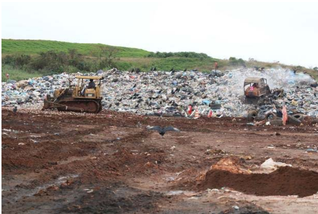
FIGURA 3 Aterro controlado do Botuquara em Ponta Grossa/PR - 2014
