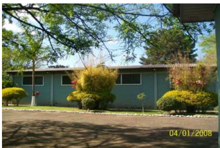
Unidade Estrutural da Fabrimed, localizada no Distrito Industrial de Telêmaco Borba- PR. Fonte: Acervo particular da autora
