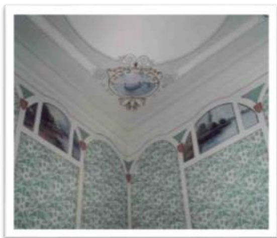
Figura 11 – Sala de Estar - 1998
