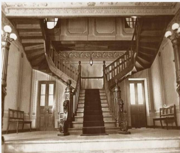
Figura 138 – Escada para piso superior
