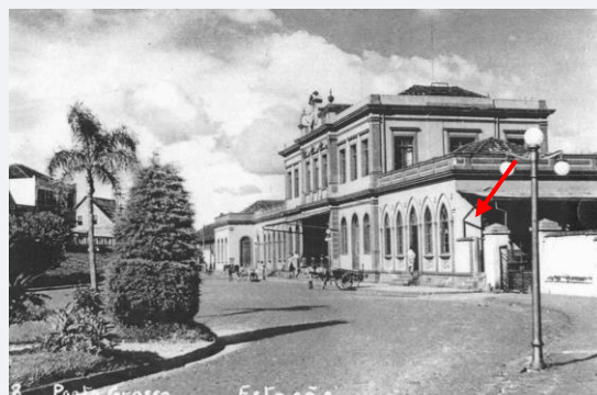
Figura 97 – Estação na década de 1940
