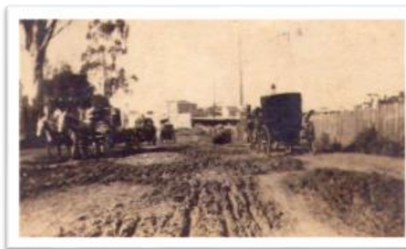
Figura 48 – Acesso Estação – Década de 1910
