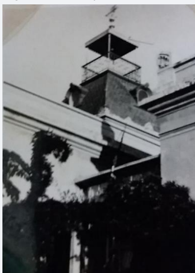
Figura 105 – Aspecto do torreão
