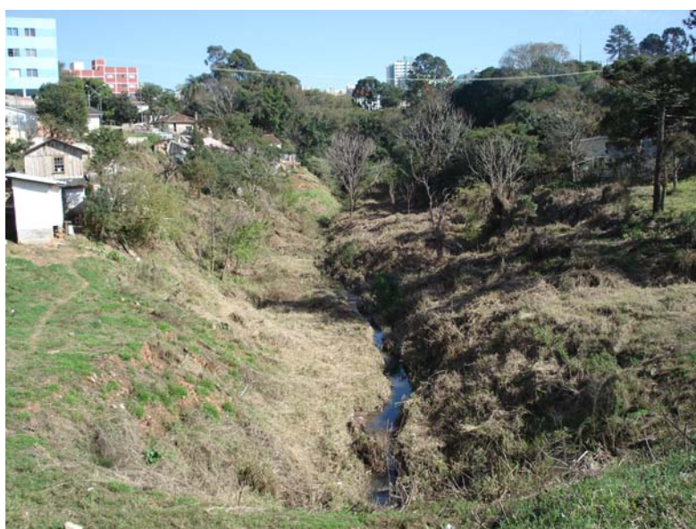
Figura 27: Vista parcial do trecho que corresponderia ao Parque Arroio Universidade I em área da possível represa. Fonte: Trabalho de campo, 2009.
