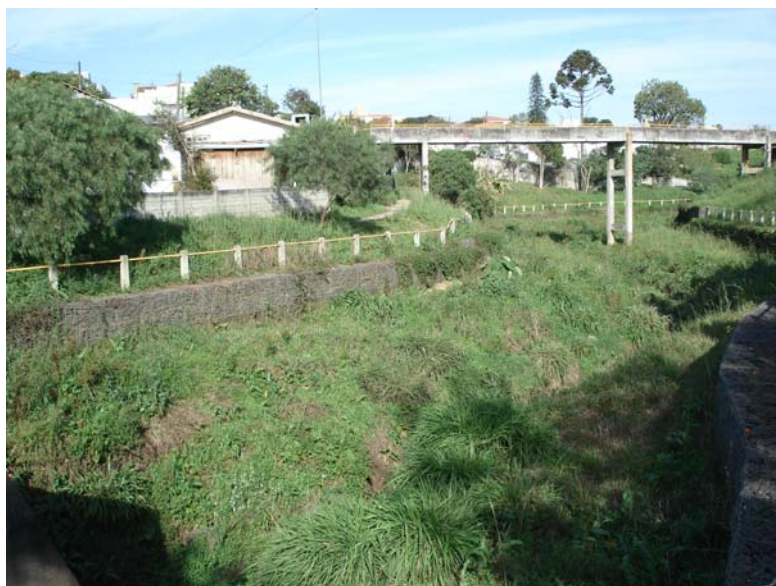
Figura 21: Passarela de concreto sobre o arroio no Parque Madureira I, com o lago desfeito. Fonte: Trabalho de campo, 2009.
