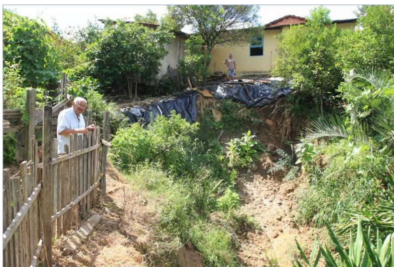
Figura 12: Instalação de lonas pretas para conter riscos de desmoronamentos às margens de afluente do Arroio Olarias. Fonte: Almeida, 2009b.
