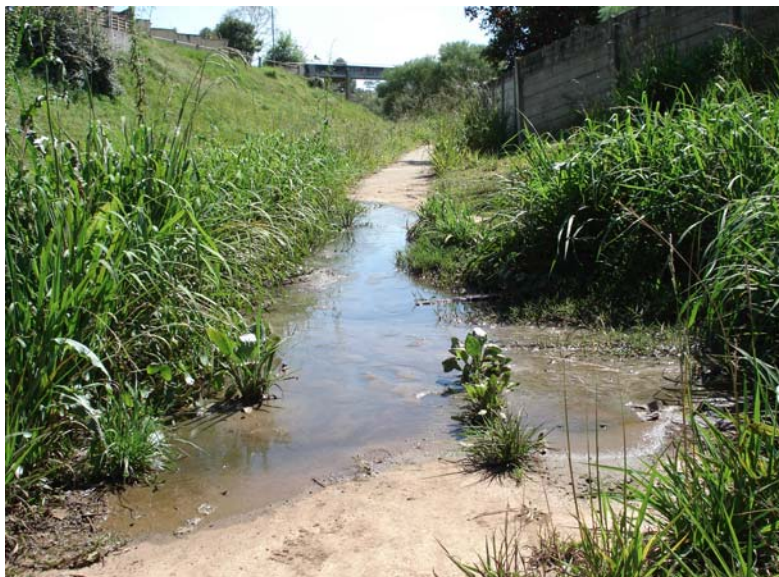
Figura 20: Lançamento irregular de esgoto sobre a calçada do parque no Madureira I.
