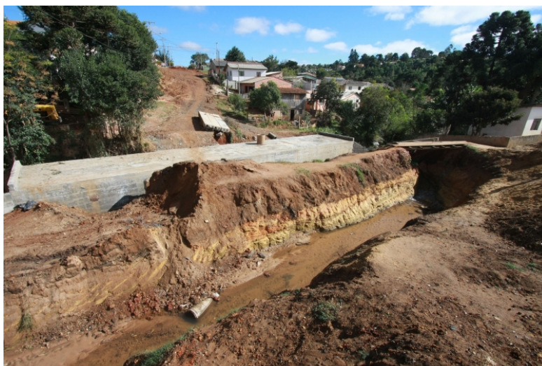
Figura 25: Bueiro celular com 27 metros de extensão colocado para canalização do curso do Arroio Madureira em trecho de via pública.
