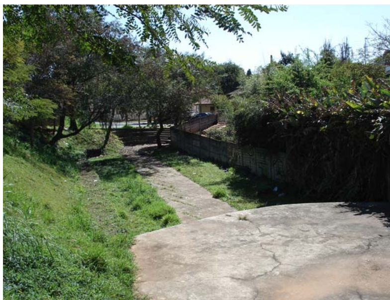
Figura 16: Calçada construída sobre o arroio canalizado no Parque Madureira II. Fonte: Trabalho de campo, 2009.
