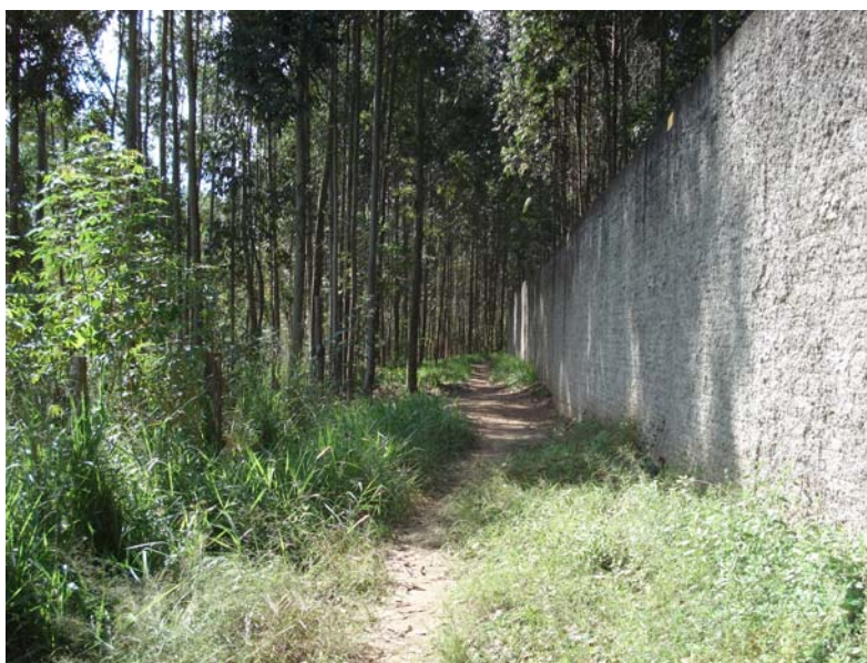
Figura 15: Muro em alvenaria (à direita) e vegetação às margens do Arroio Madureira (à esquerda).
