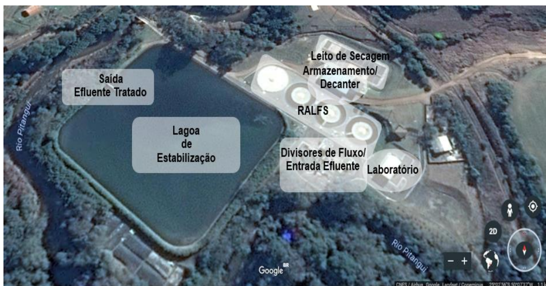
FIGURA 10 – Imagem aérea da ETE Verde, Ponta Grossa, Brasil (Google Earth).
