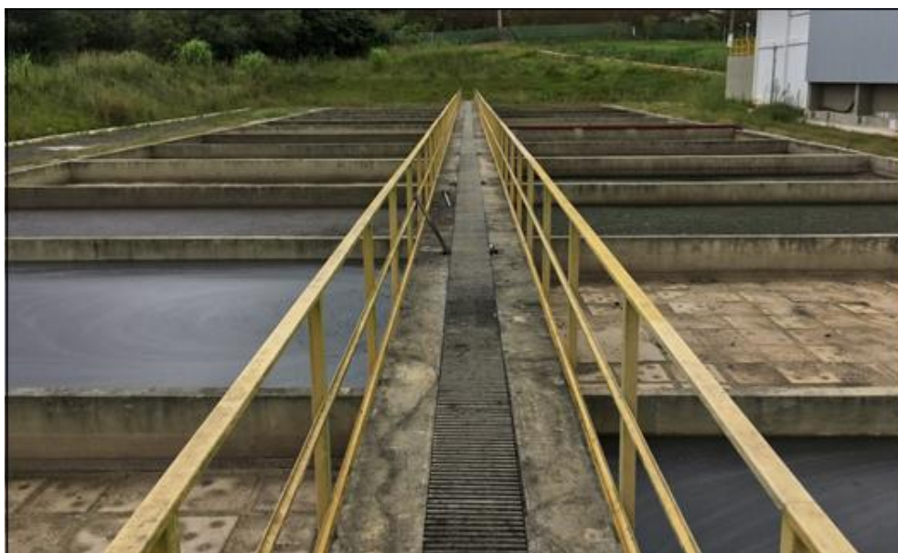
FOTOGRAFIA 6 - Leitos de secagem natural do lodo (ETE Verde / Ponta Grossa / Brasil)
