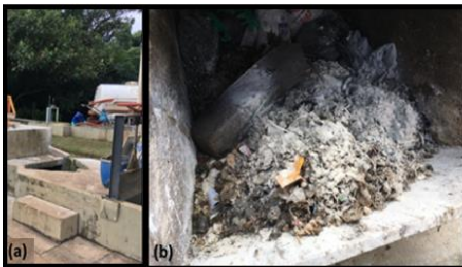
FOTOGRAFIA 3 - (a) Grade para retirada de grosseiros; (b) material grosseiro retirado
