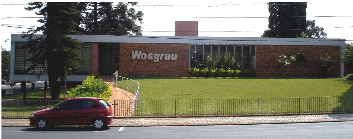
Figura 32 – Foto Residência RPW Empreendimentos Imobiliários - Década 1960 Fonte: Acervo de MIGLIORINI, março 2006
