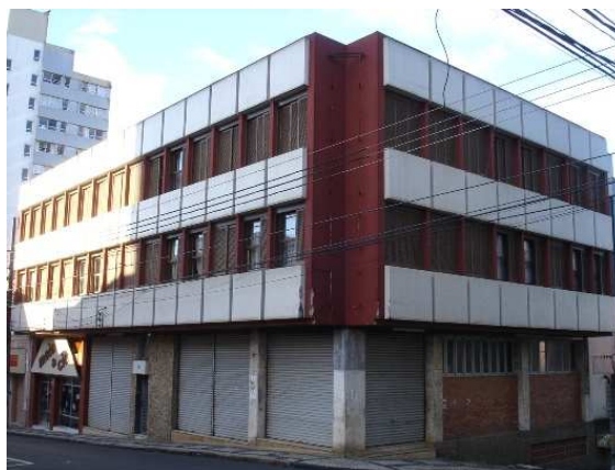
Figura 78 – Foto Edificação Cine Inajá Fonte: Acervo de MIGLIORINI, março 2007
