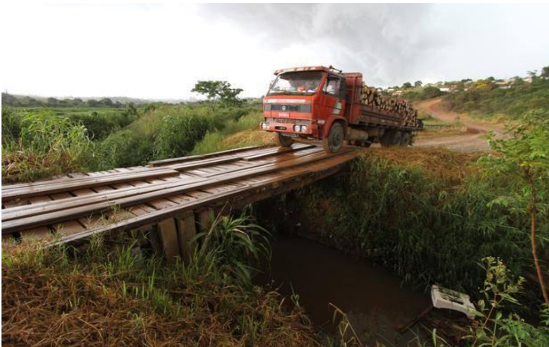
Figura 3: Ponte de ligação entre ruas, no Arroio Olarias
