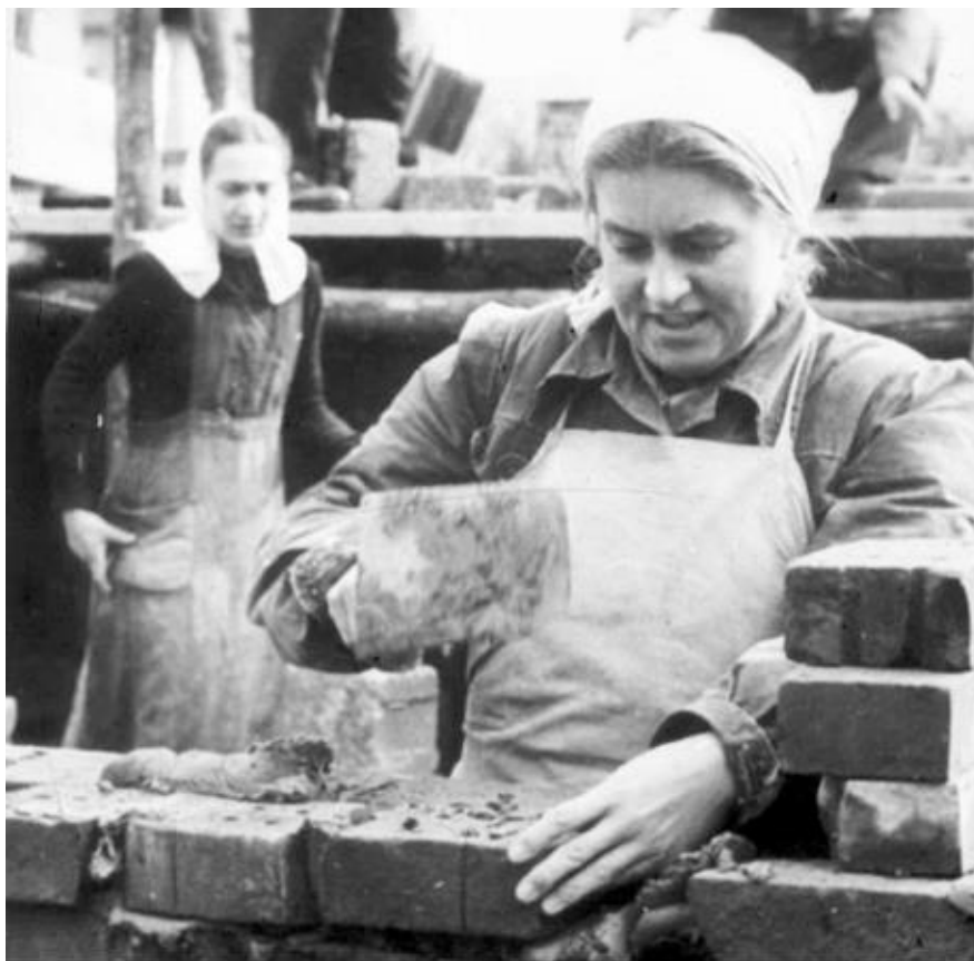
FIGURA 15 - Irmã construindo uma parede.
