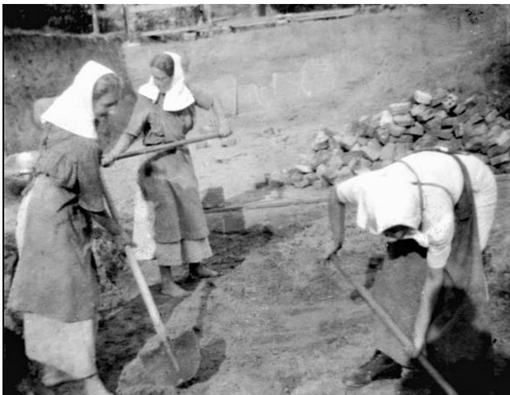
FIGURA 16 - Irmãs construindo a fundação.
