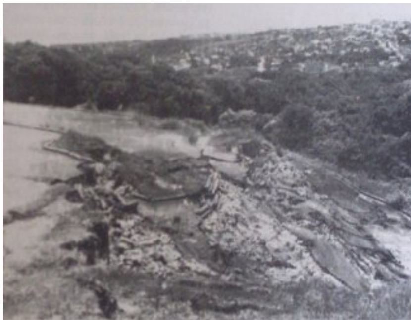
Figura 15 - Foto de escorregamento ocorrido no estacionamento da PMPG FONTE: JORNAL DA MANHÃ. 17 DE JANEIRO DE 1995
