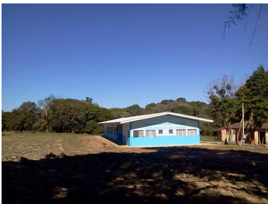
Imagem 5: Fachada da escola nova. Fonte: a autora.
