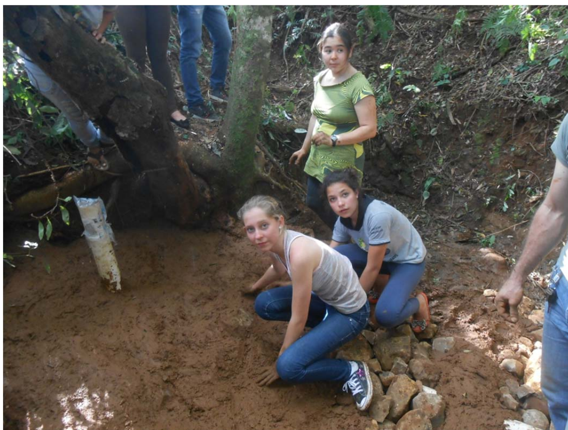
Figura 64: Finalização da proteção da nascente
