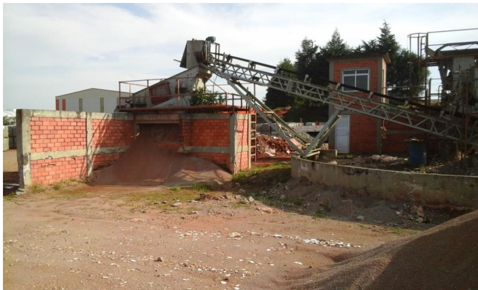
Figura 4 – Reciclagem de resíduos de construção e demolição por meio da trituração em forma de agregado
