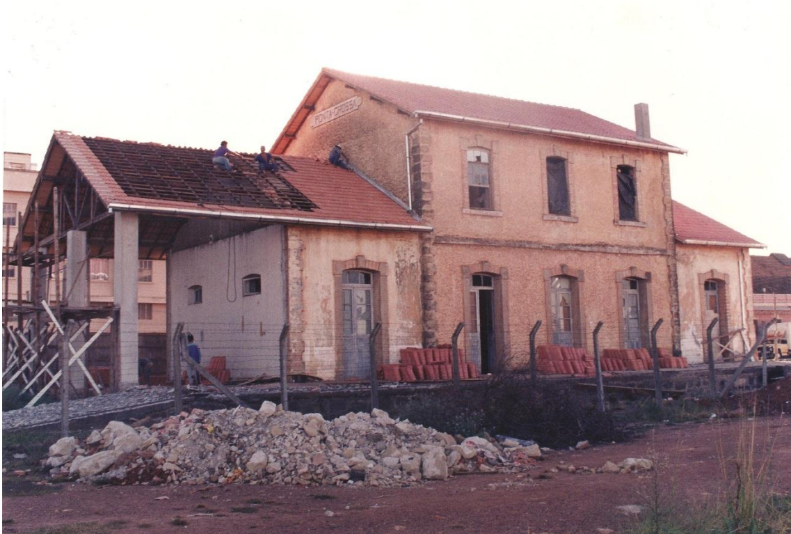
Fotografia 7 – Reforma Estação Paraná
