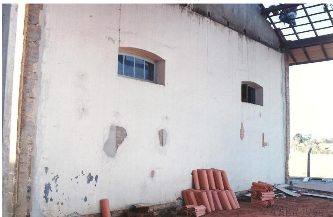
Fotografia 6 – Reforma Estação Paraná
