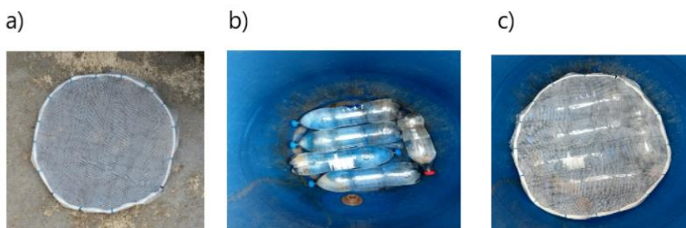
Figura 11- Sistema de dreno do reator facultativo a) tela para dreno b) espaçamento para dreno c) tela sobre o espaçador alocado dentro do reator
