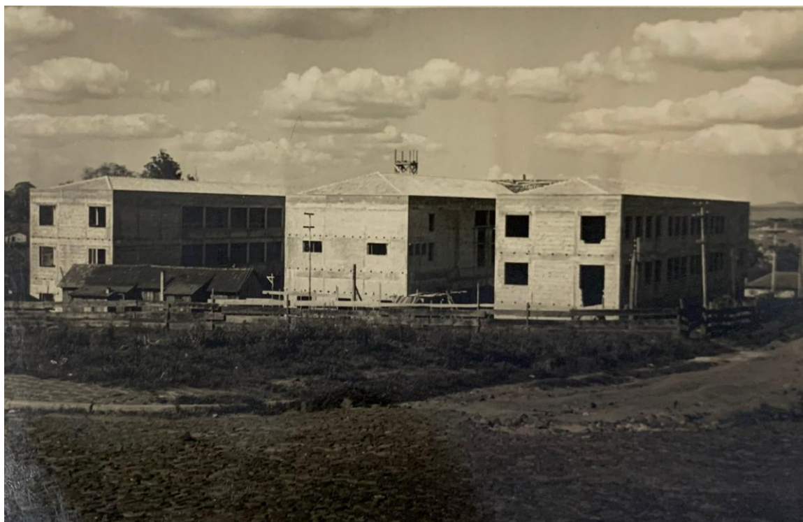
Figura 26 – Visão dos fundos do Edifício das Faculdades de Ponta Grossa em 1958
