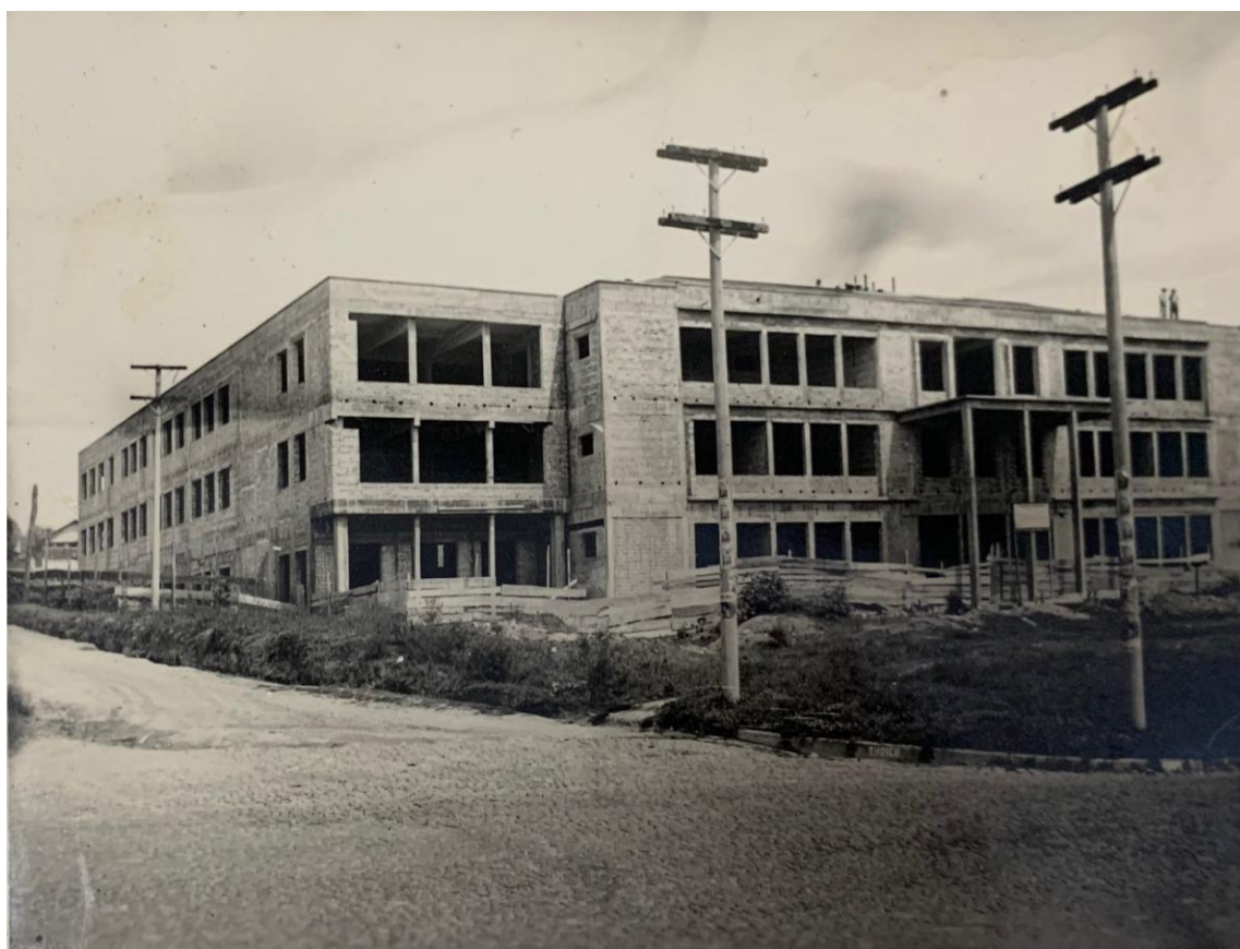
Figura 25 - Visão frontal esquerda do Edifício das Faculdades de Ponta Grossa em 1958
