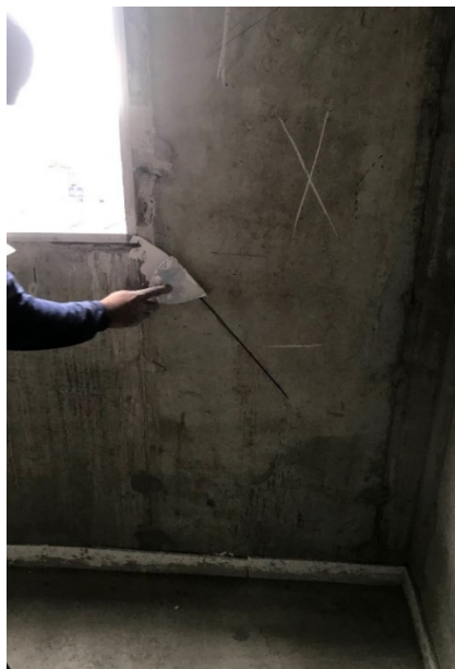
Figura 47- Aplicação de gesso
