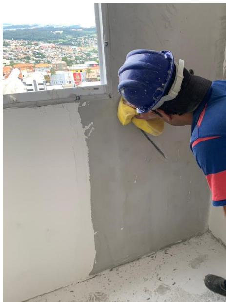
Figura 51- Limpeza do substrato
