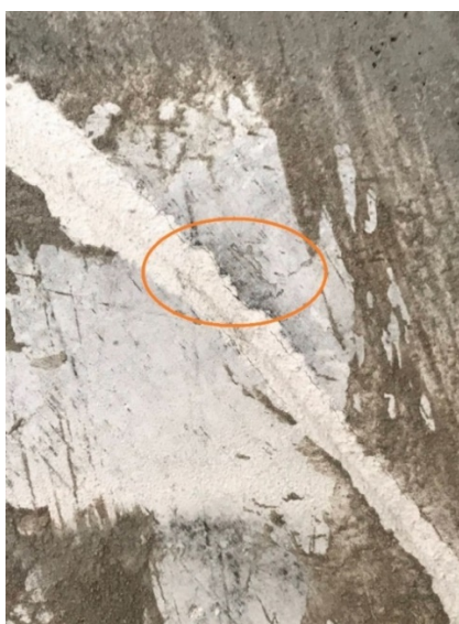
Figura 48- Microfissuras
