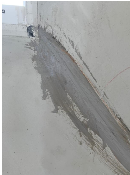
Figura 52- Aplicação de PU
