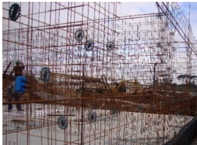
Figura 22- Execução de armaduras
