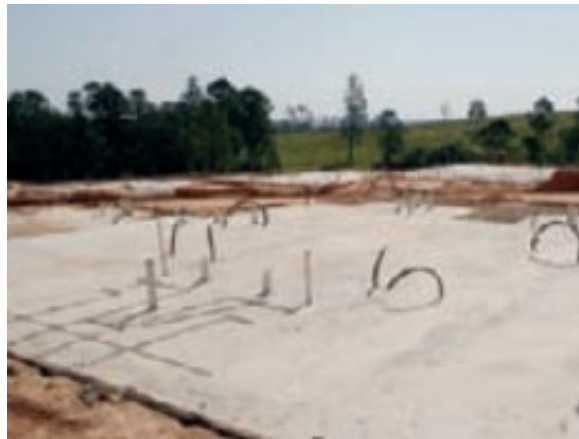
Figura 18- Fundação do tipo radier
