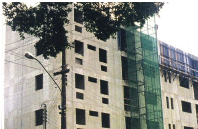
Figura 2-Obra construída em paredes de concreto
