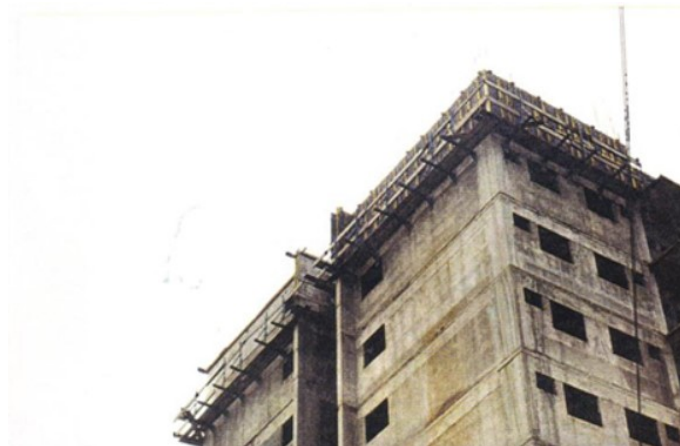
Figura 1- Obra construída em paredes de concreto
