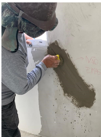
Figura 56- Aplicação de impermeabilizante
