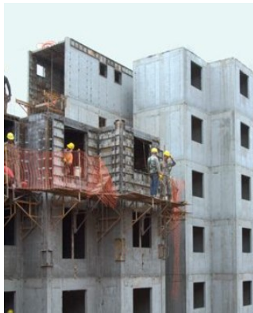
Figura 7-Edificação pós desforma
