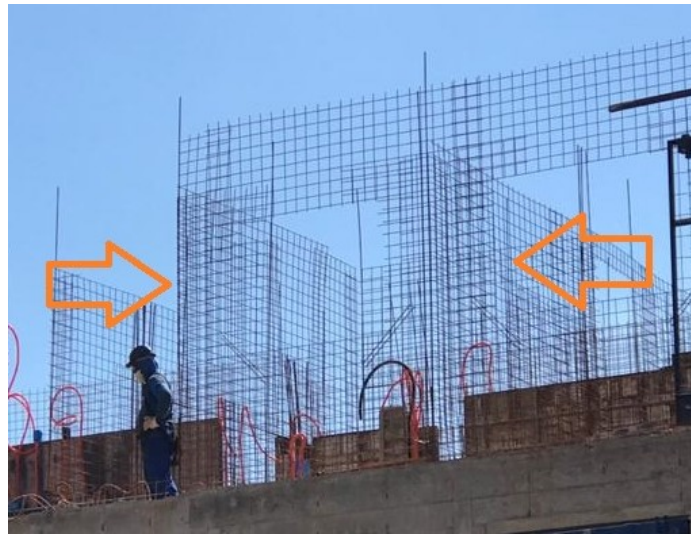
Figura 41- Reforços estruturais no perímetro da esquadria
