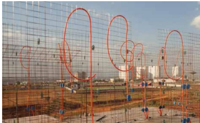
Figura 23- Instalações elétricas e hidráulicas
