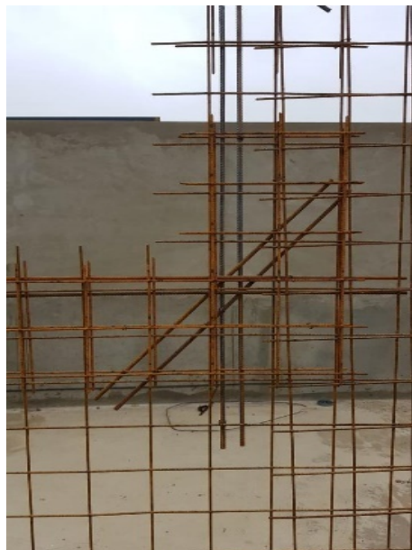
Figura 42- Reforços inclinados na diagonal
