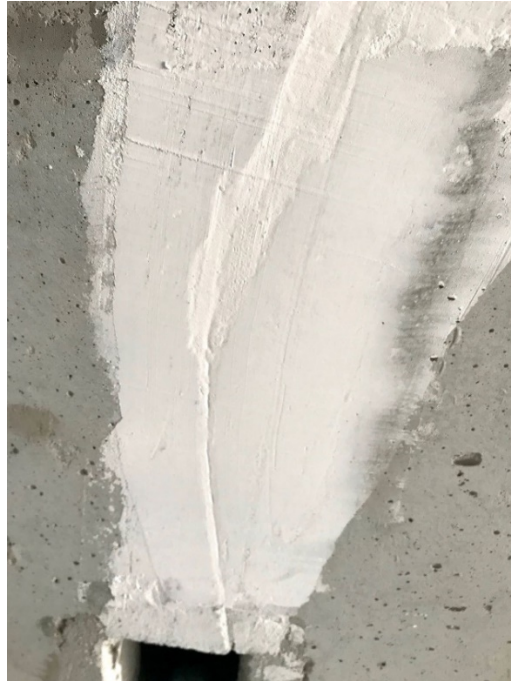
Figura 49- Fissura passiva
