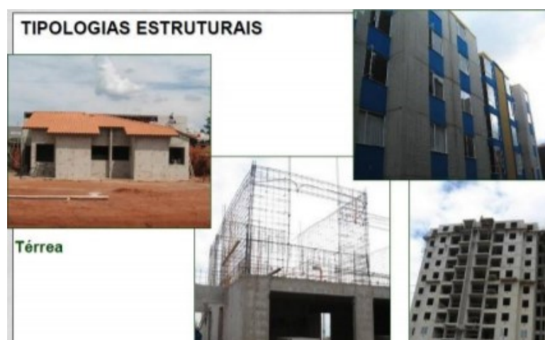
Figura 5-Tipologia das estruturas em parede de concreto
