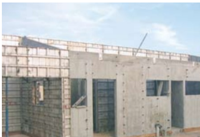
Figura 28- Desforma
