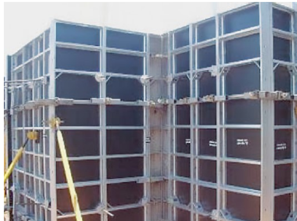
Figura 14 - Forma metálica + compensado
