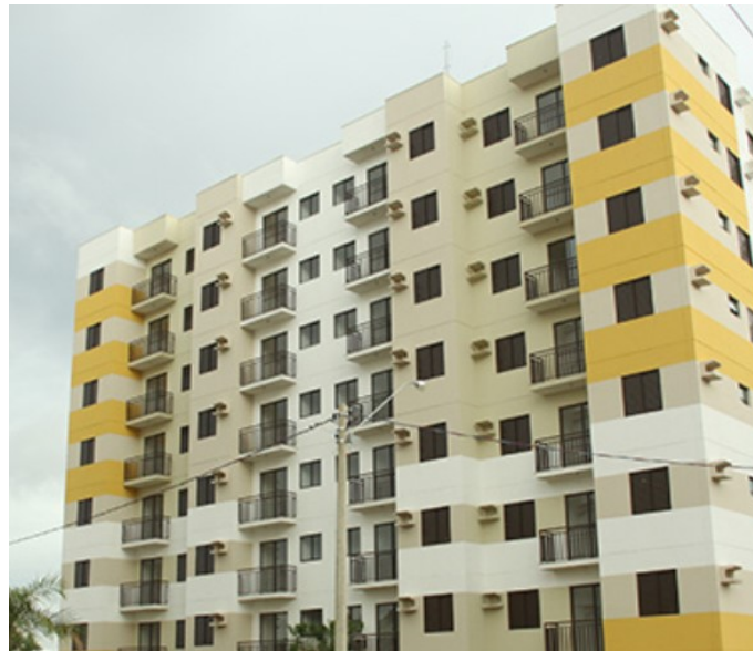
Figura 3- Obra da empresa Rodobens
