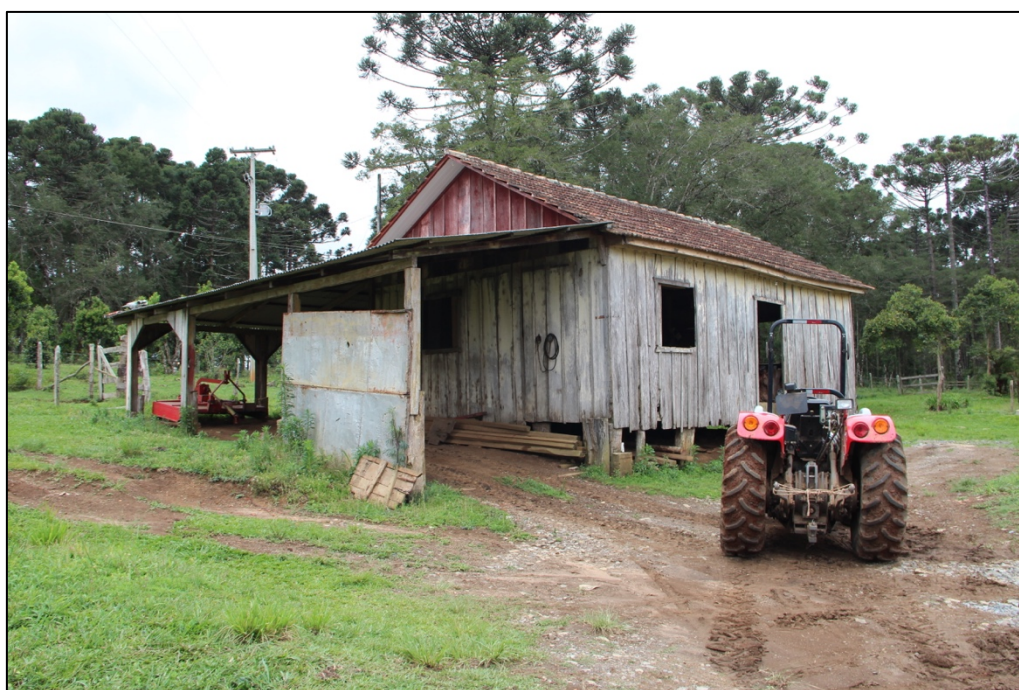
Figura 6: Galpão da propriedade construído em estilo semelhante a outras propriedades da região.
