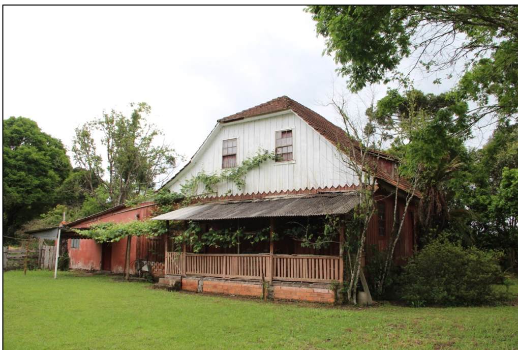
Figura 9 Em perspectiva lateral, com destaque para a varanda e o segundo andar com duas amplas janelas.
