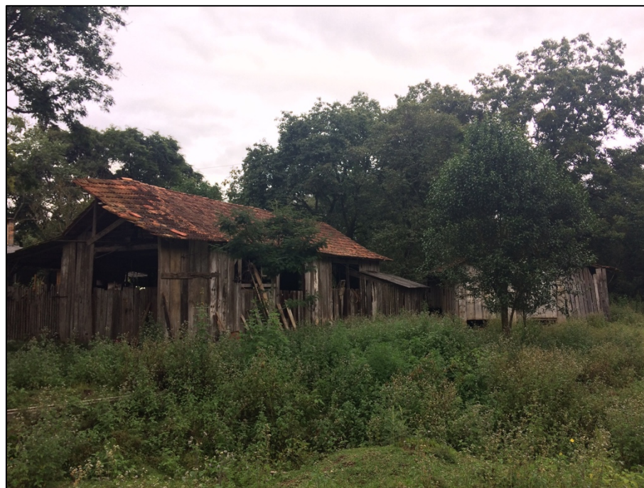
Figura 2 :Antiga construção que abrigara uma oficina
