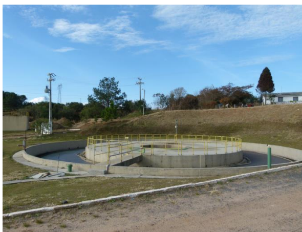
Figura 2.5 – RALF (Reator Anaeróbio de Manto de Lodo e Fluxo Ascendente).
