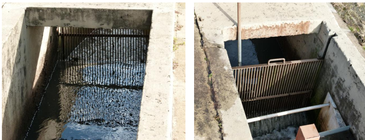
Figura 2.3(a) e 2.3(b) – Gradeamentos manuais.
