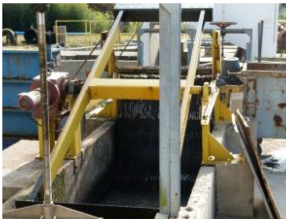
Figura 2.2 – Gradeamento automatizado.
