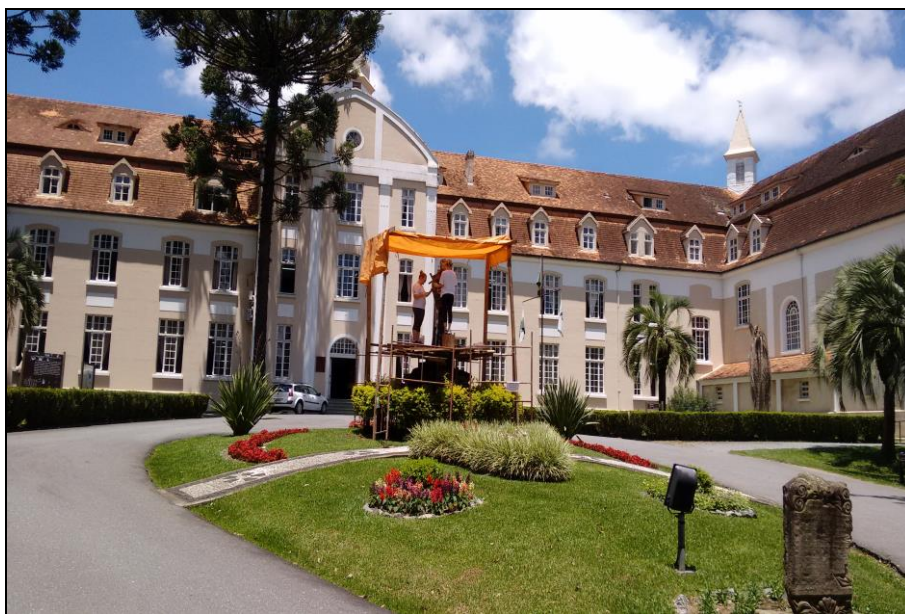
Figura 13- Fachada principal da sede do antigo seminário. Fonte: Autor, 2015.
