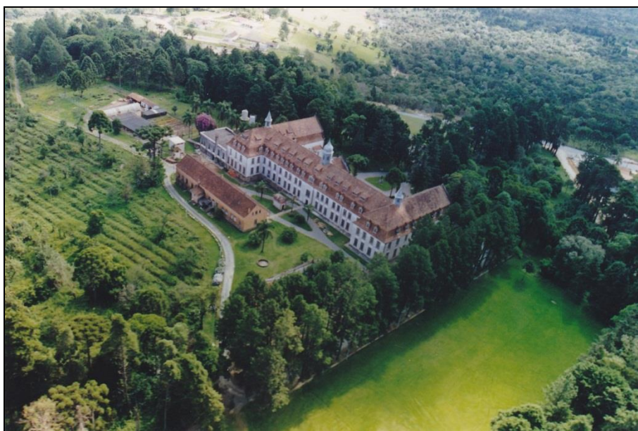
Figura 23 - Vista aérea dos fundos do prédio principal, anexos I e II e do campo de lazer. Fonte: Acervo de Maria da Glória França Foohs (2000)
