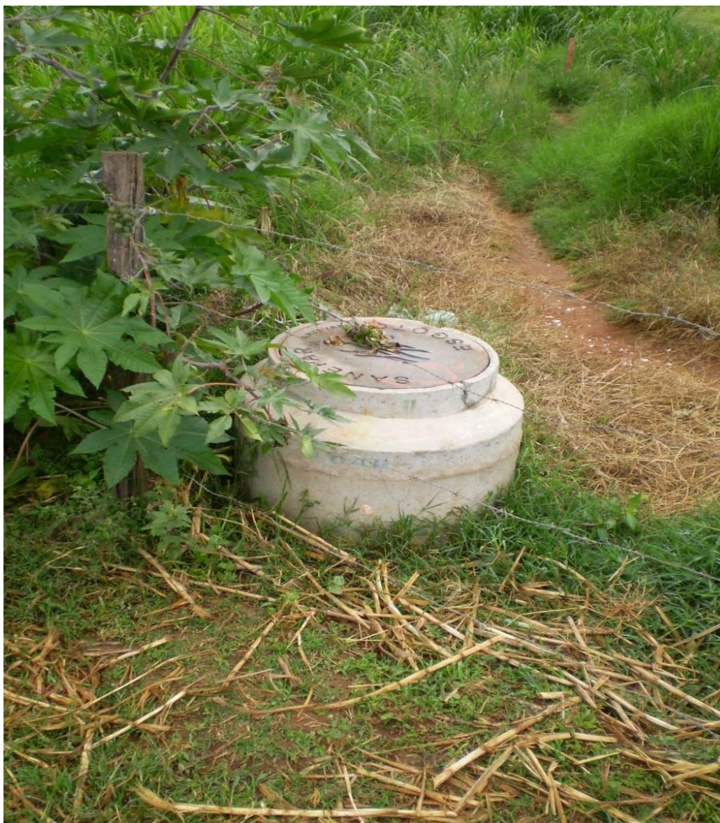
Foto 04 – Área com coleta de esgoto
