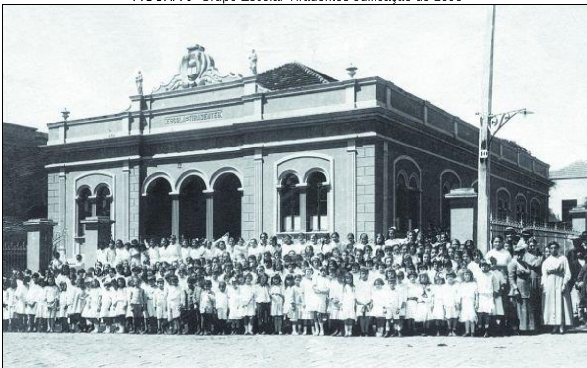
FIGURA 6- Grupo Escolar Tiradentes edificação de 1895
