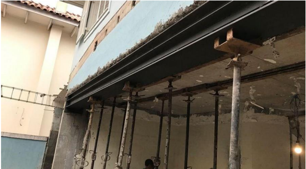
Figura 29 - Reforço com viga metálica
