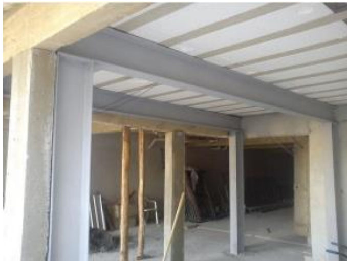
Figura 16 - Perfis metálicos apoiados sobre pilares metálicos
