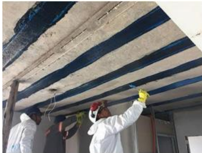
Figura 17 - Aplicação de polímero reforçado com fibras
