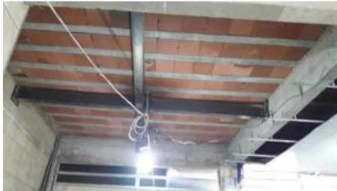
Figura 15 - Perfil metálico apoiado em vigas existentes
