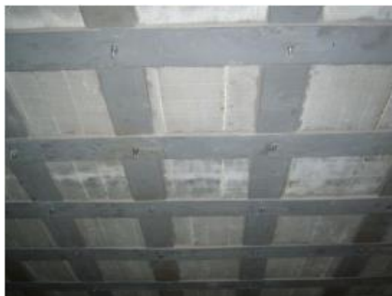
Figura 14 - Reforço de laje com chapa metálica
