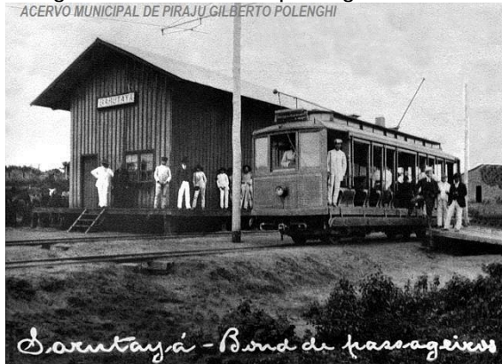
Fotografia A7 – bonde de passageiros na subestação do distrito de Sarutaiá
