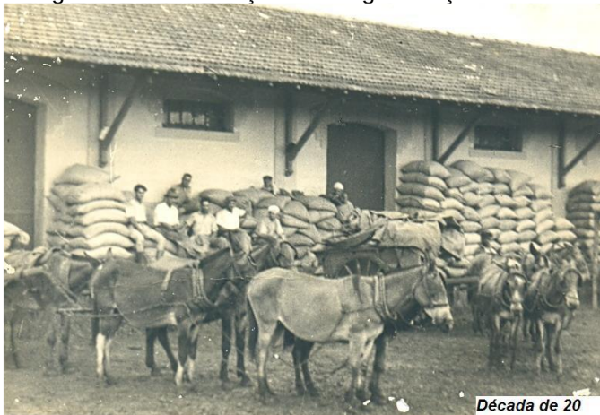
Fotografia A5 – Instalação da antiga Estação Ferroviária
