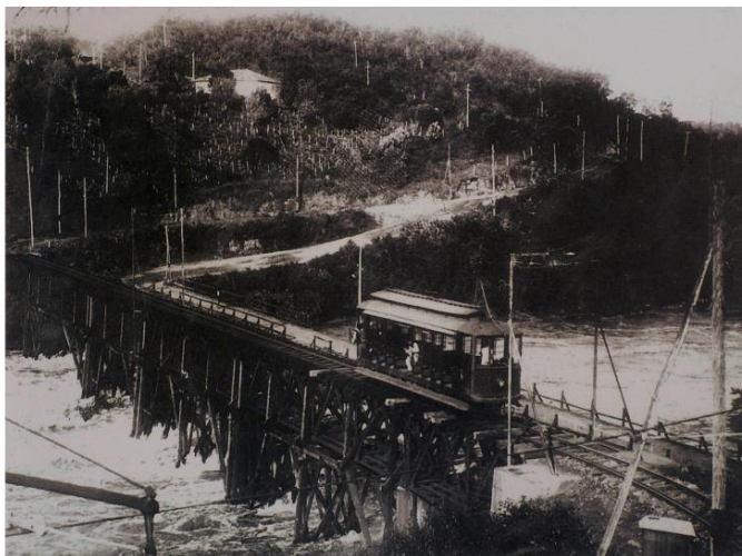
Fotografia 2 – Ponte metálica sobre o rio Paranapanema (entre 1910 e 1929)
