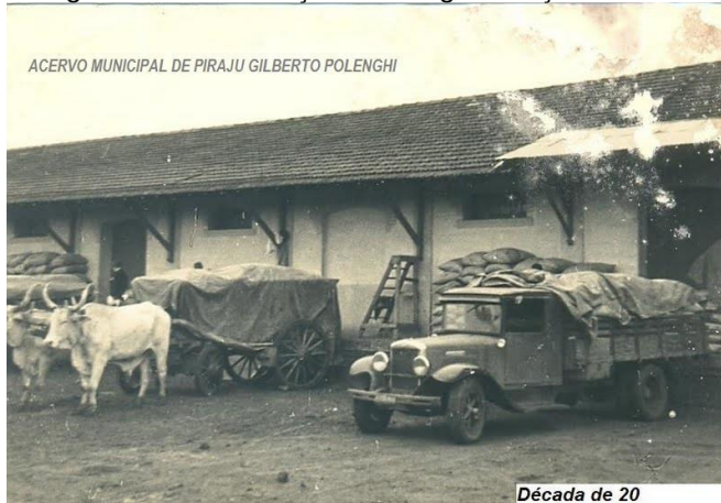
Fotografia A6 - Instalação da antiga Estação Ferroviária
