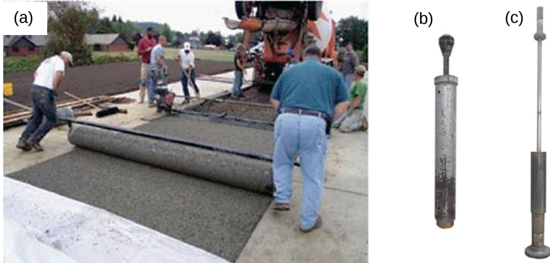
Figura 9 – Compactação (a) em campo e (b) soquetes de compactação Proctor e (c) Marshall
