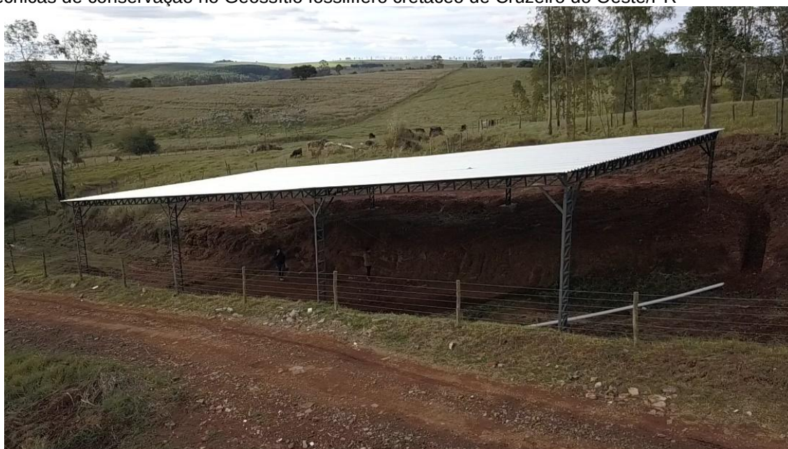
Fotografia 3 - Infraestrutura de cobertura e tubulações para disciplinamento de água pluvial, como técnicas de conservação no Geossítio fossilífero cretáceo de Cruzeiro do Oeste/PR
