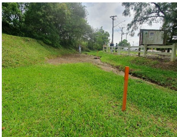
Fotografia 6 - Piquetes/estacas no geossítio (novembro de 2024), indicando a execução de levantamento topográfico
