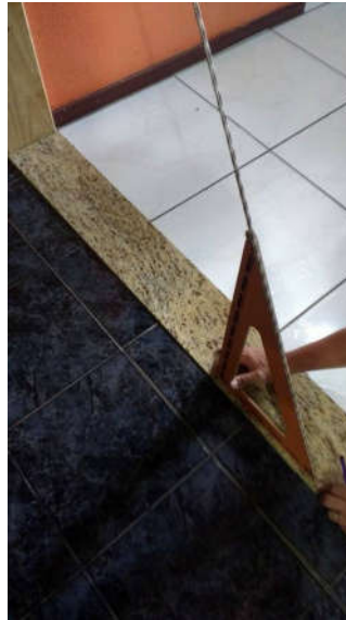
Figura 138: Altura da Parede - 2 Fonte: o autor
