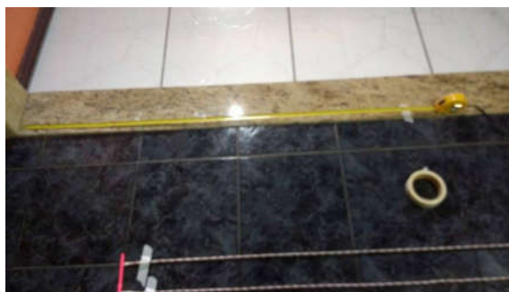
Figura 141: Altura da Parede - 5 Fonte: o autor
