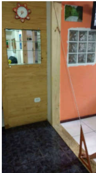
Figura 137: Altura da Parede - 1 Fonte: o autor
