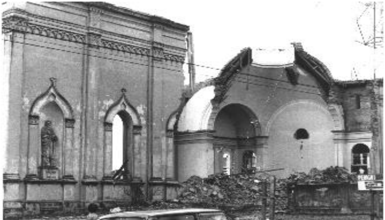
Figura 7 - Demolição da Catedral de Sant’Ana, 1978.
