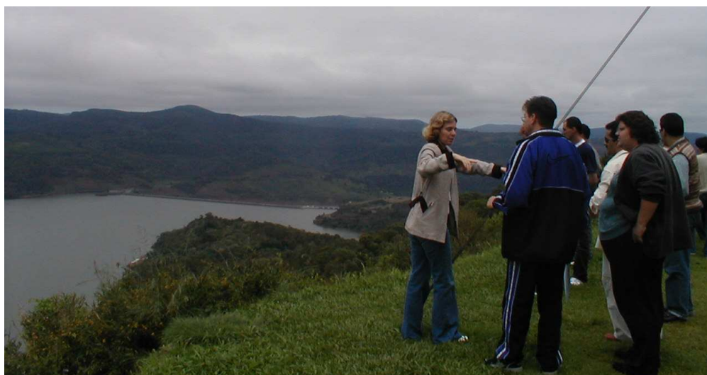
FOTO 3 – BARRAGEM VISTA DO 2º MIRANTE.
