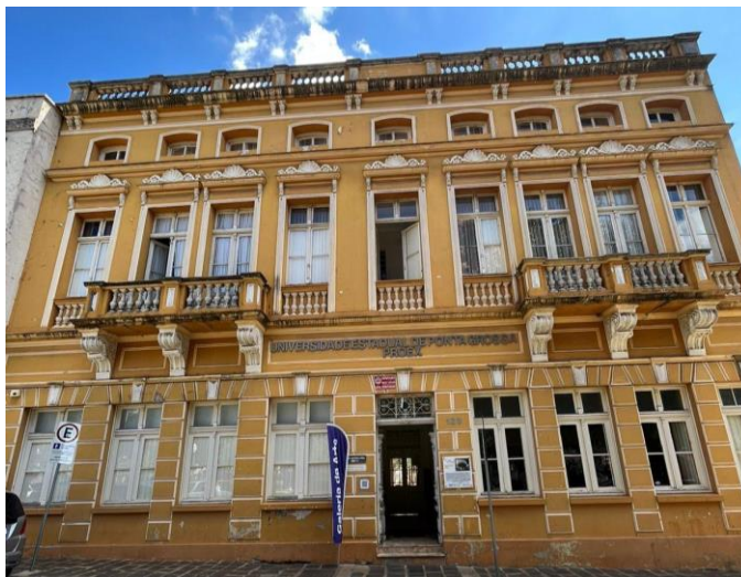
Foto 3 - Fachada PROEX - Ponta Grossa
